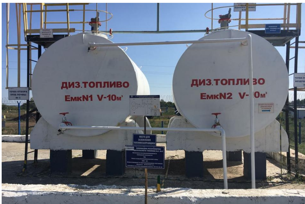
Рисунок 1 - Общий вид резервуаров РГС-10 №1е, 2е (БКНС «Ерзовка»)
