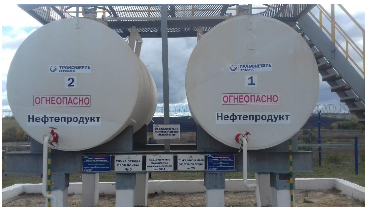
Рисунок 2 - Общий вид резервуаров РГС-10 №№1, 2 (БКНС «Бугуруслан»)
