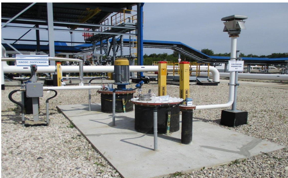
Рисунок 1 - Общий вид места установки резервуара РГС-16 № 1
