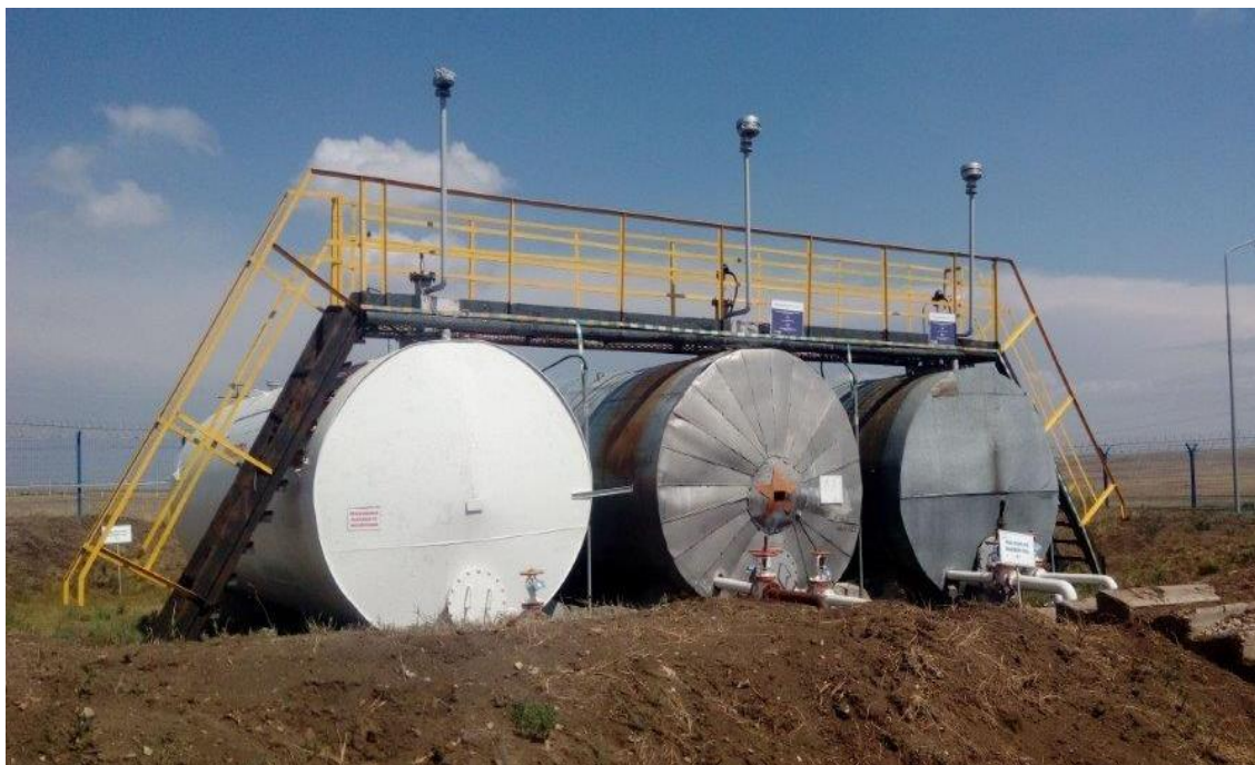
Рисунок 1 - Общий вид резервуаров РГС-50 №№ 1, 2, 3
