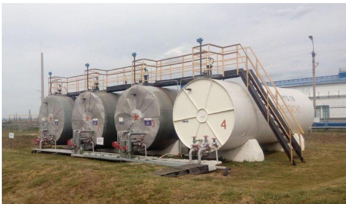
Рисунок 2 - Общий вид резервуаров РГС-75 №№ 1, 2, 3, 4
