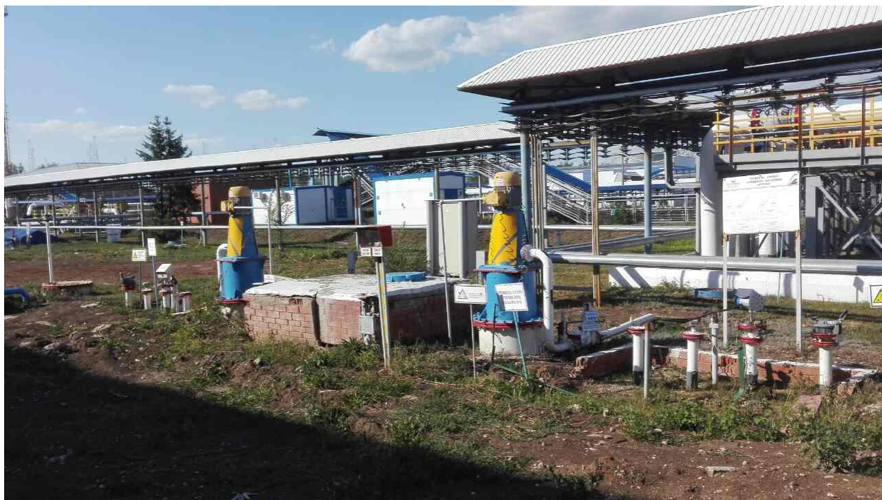
Рисунок 1 - Общий вид резервуаров
