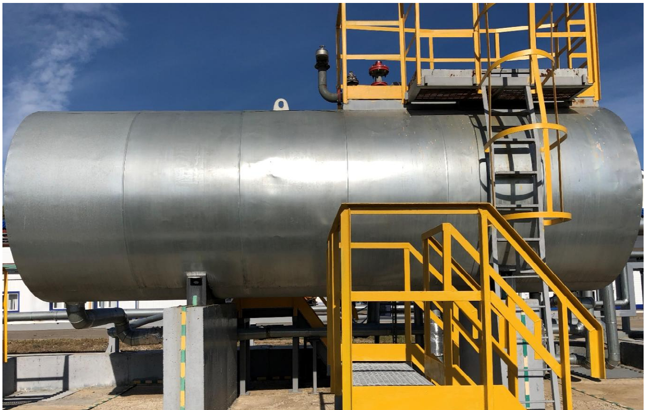
Рисунок 1 - Общий вид резервуара РГС-17
