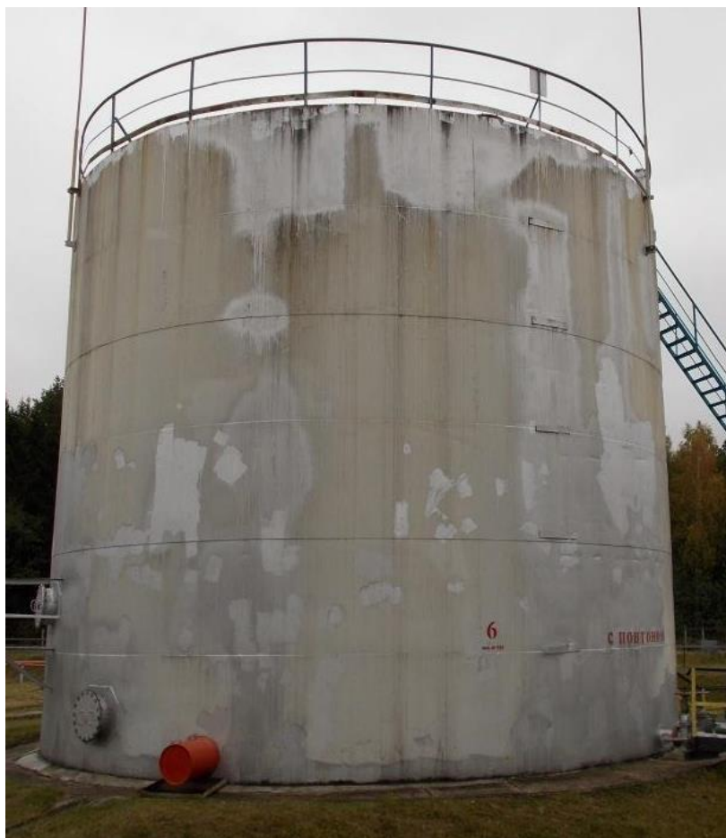
Рисунок 2 - Общий вид резервуара стального вертикального цилиндрического РВС-700
