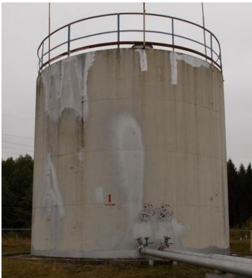
Рисунок 1 - Общий вид резервуара стального вертикального цилиндрического РВС-200
