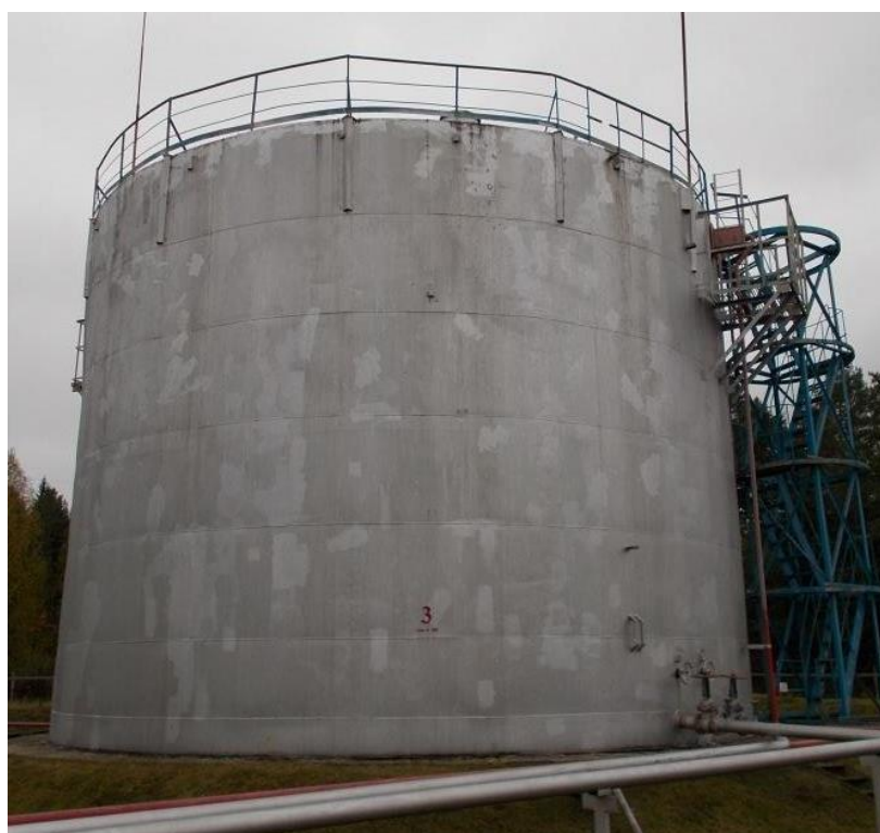
Рисунок 3 - Общий вид резервуара стального вертикального цилиндрического РВС-1000
