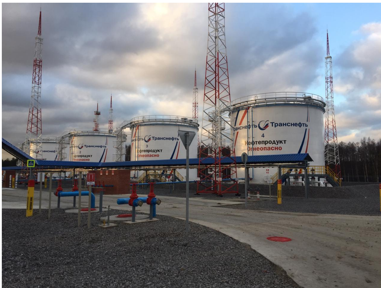
Рисунок 1 - Общий вид резервуаров РВС-2000
