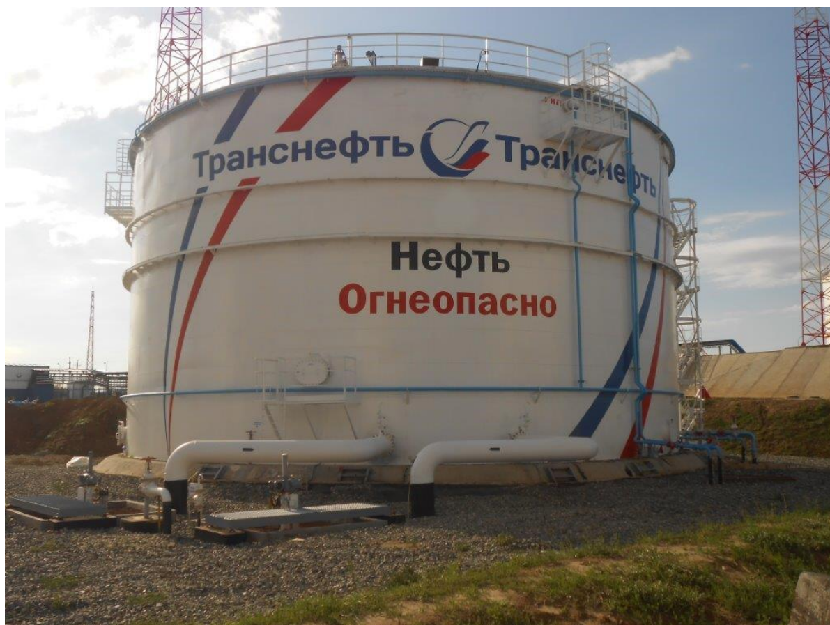
Рисунок 2 - Общий вид резервуара вертикального стального цилиндрического РВСП-5000
