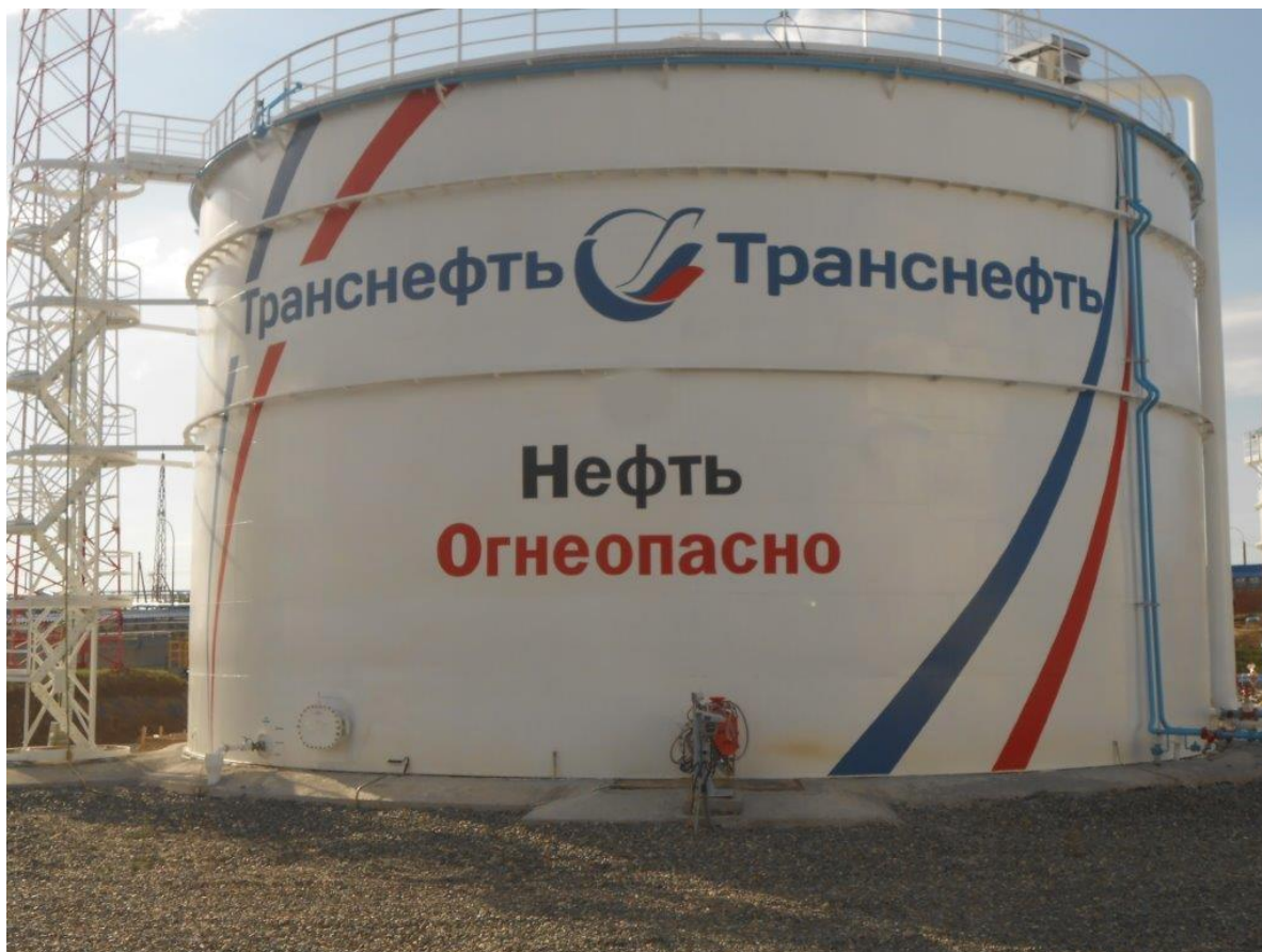
Рисунок 1 - Общий вид резервуара вертикального стального цилиндрического РВС-5000
