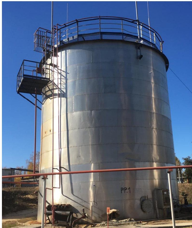
Рисунок 1 - Общий вид резервуара стального вертикального цилиндрического РВС-1000
