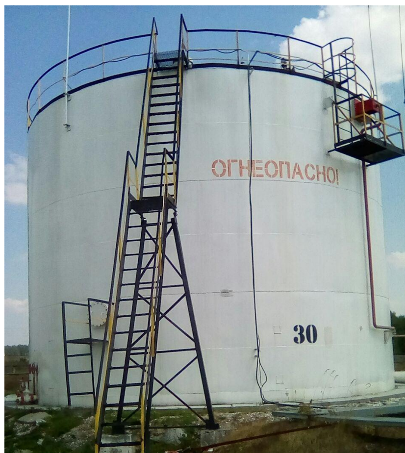
Рисунок 3 - Общий вид резервуара стального вертикального цилиндрического РВС-1000, РВСП-1000
