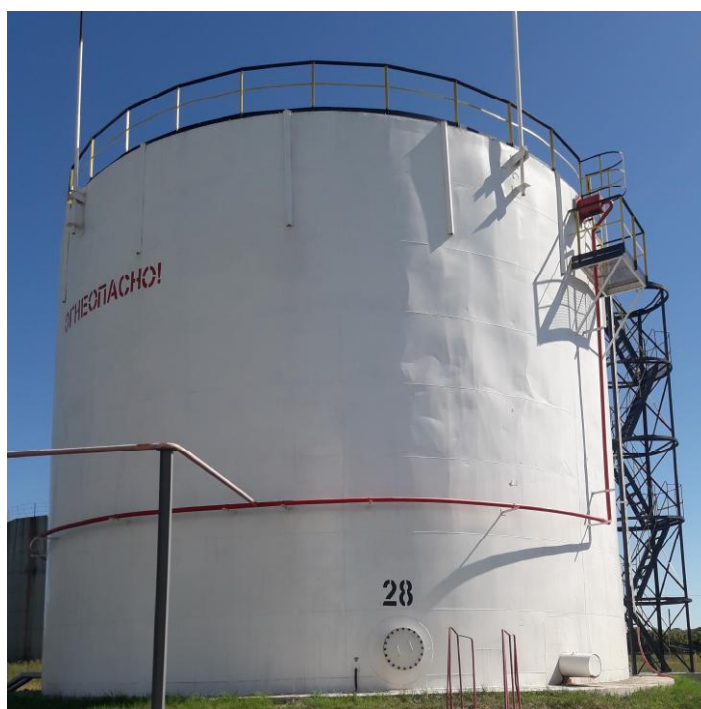
Рисунок 2 - Общий вид резервуара стального вертикального цилиндрического РВС-2000
