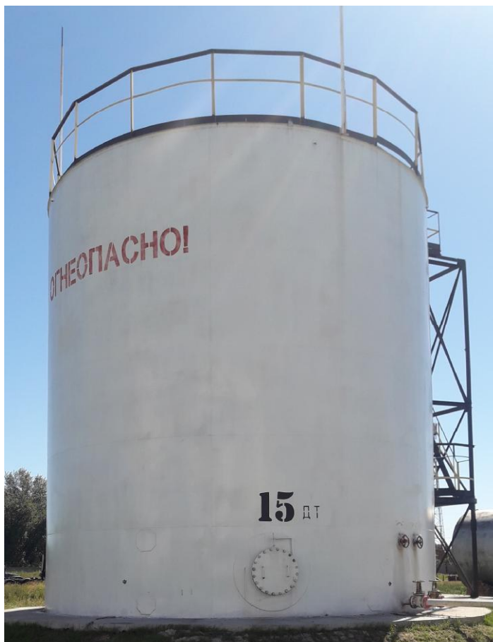
Рисунок 1 - Общий вид резервуара стального вертикального цилиндрического РВС-400
