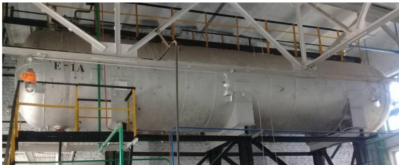
Рисунок 1 - Общий вид резервуара стального горизонтального цилиндрического РГС-50
