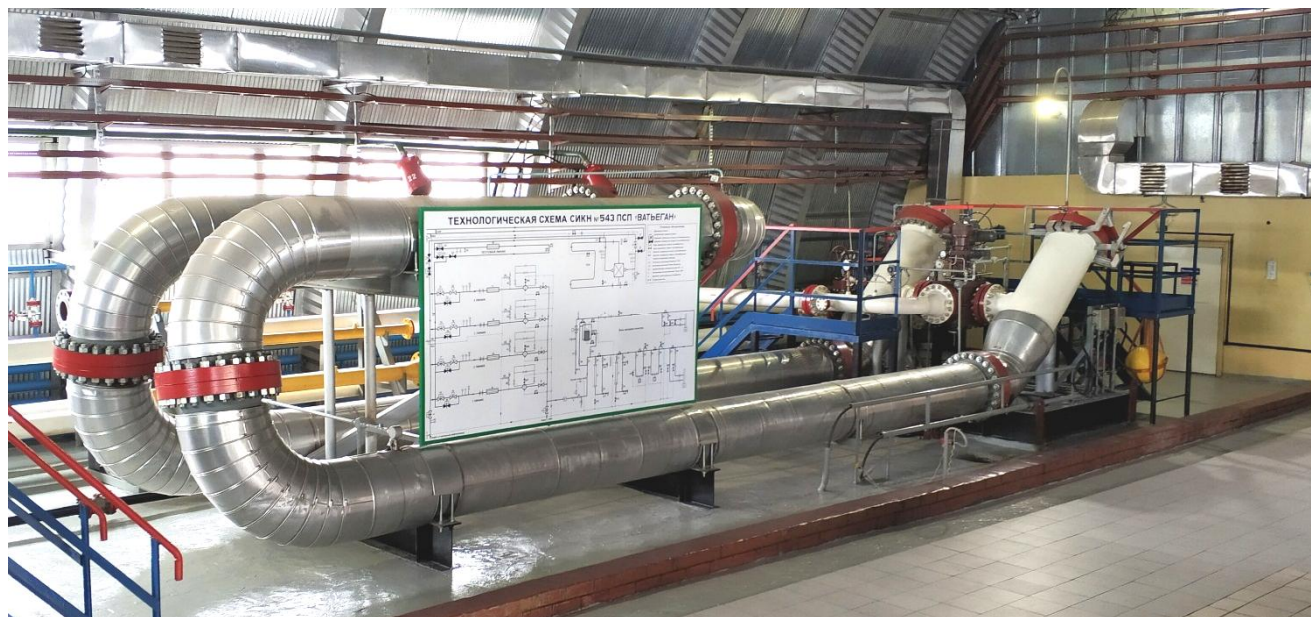
Рисунок 1 – Общий вид установки поверочной трубопоршневой двунаправленной Smith-1100
