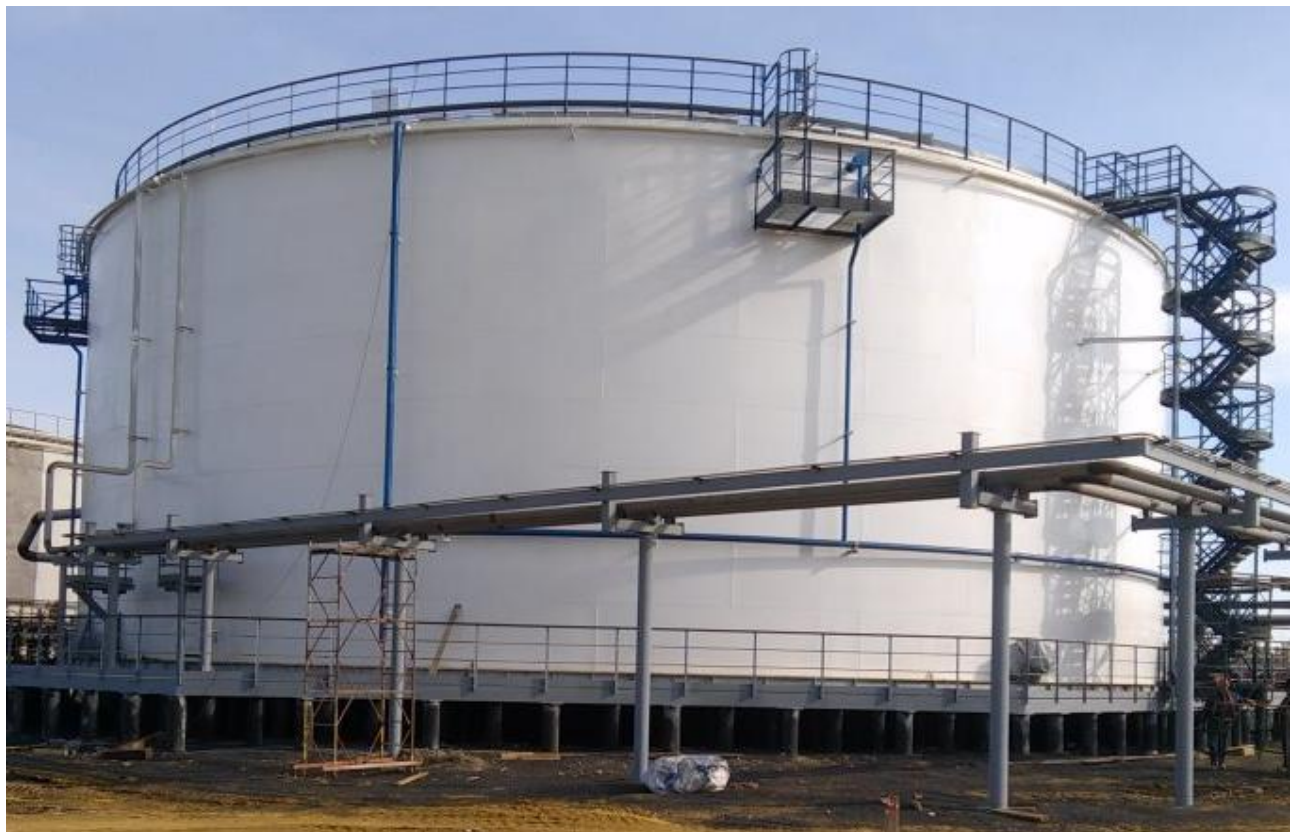
Рисунок 1 - Общий вид резервуара стального вертикального цилиндрического РВС-10000
