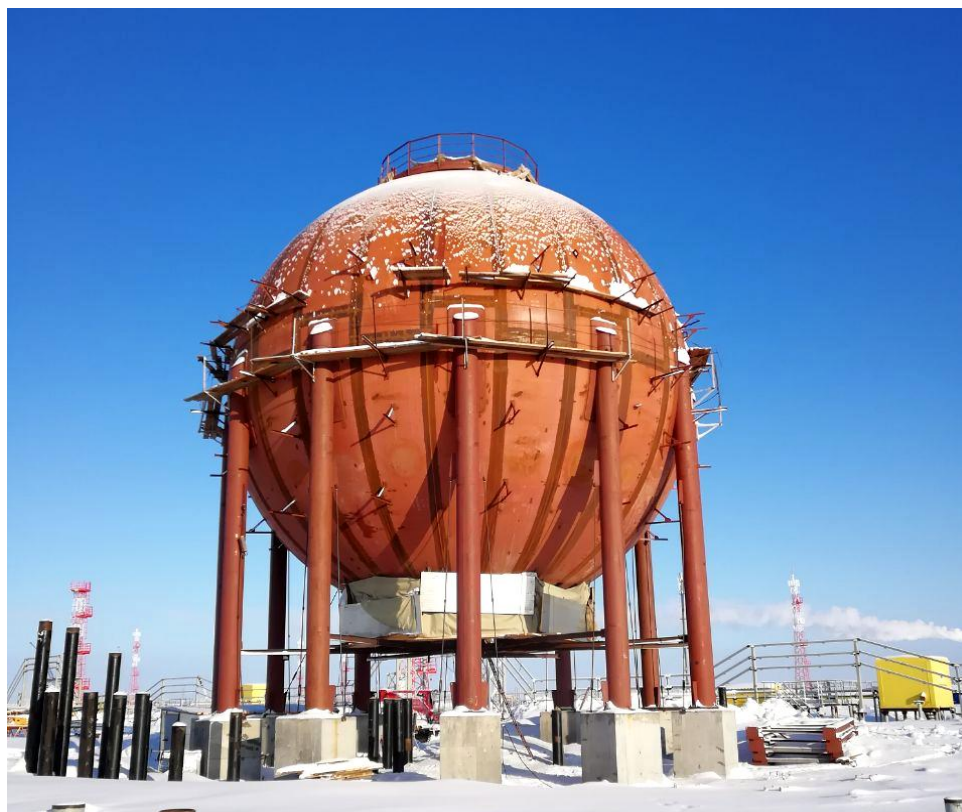
Рисунок 1 - Общий вид резервуара РШС-2000
