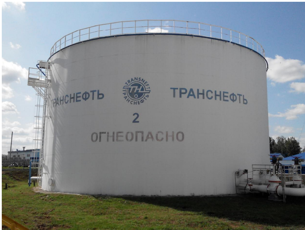
Рисунок 1 - Общий вид резервуаров вертикальных стальных цилиндрических РВСП-5000
