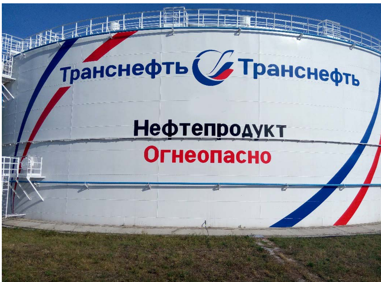
Рисунок 4 - Общий вид резервуаров вертикальных стальных цилиндрических РВС-20000
