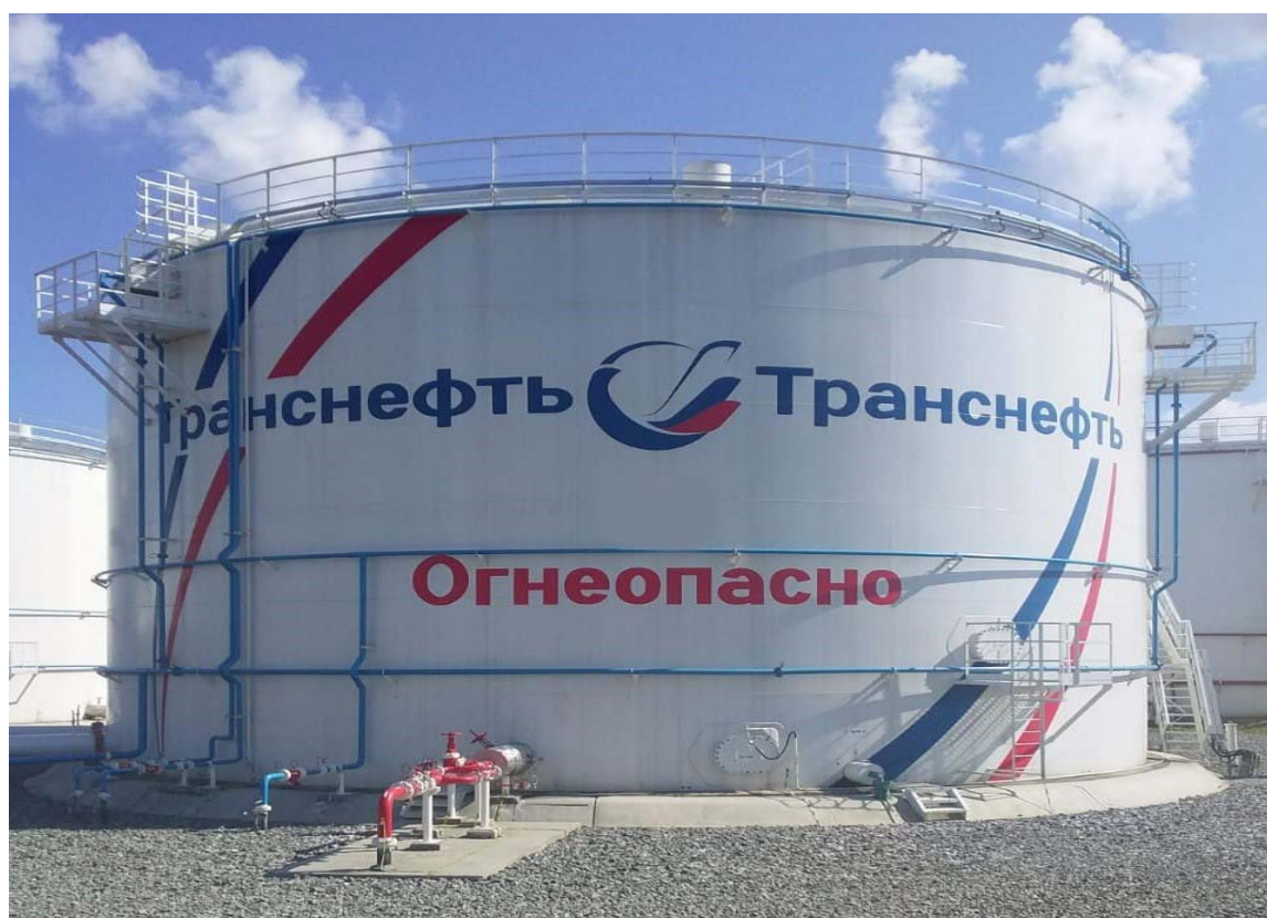
Рисунок 5 - Общий вид резервуаров вертикальных стальных цилиндрических РВСП-5000
