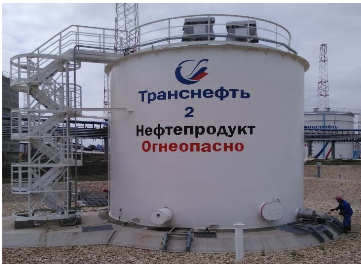
Рисунок 1 - Общий вид резервуаров вертикальных стальных цилиндрических РВС-400
