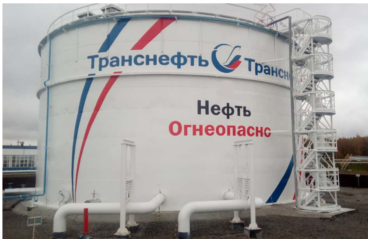
Рисунок 2 - Общий вид резервуаров вертикальных стальных цилиндрических РВС-5000
