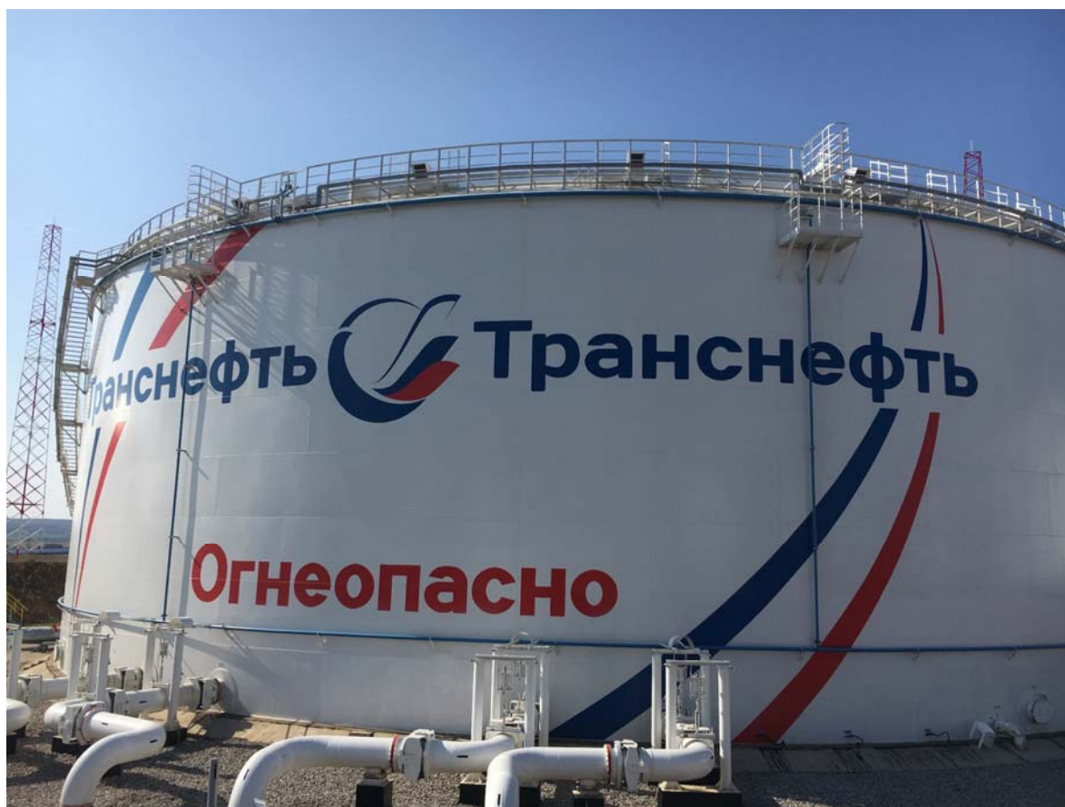
Рисунок 7 - Общий вид резервуаров вертикальных стальных цилиндрических РВСП-20000
