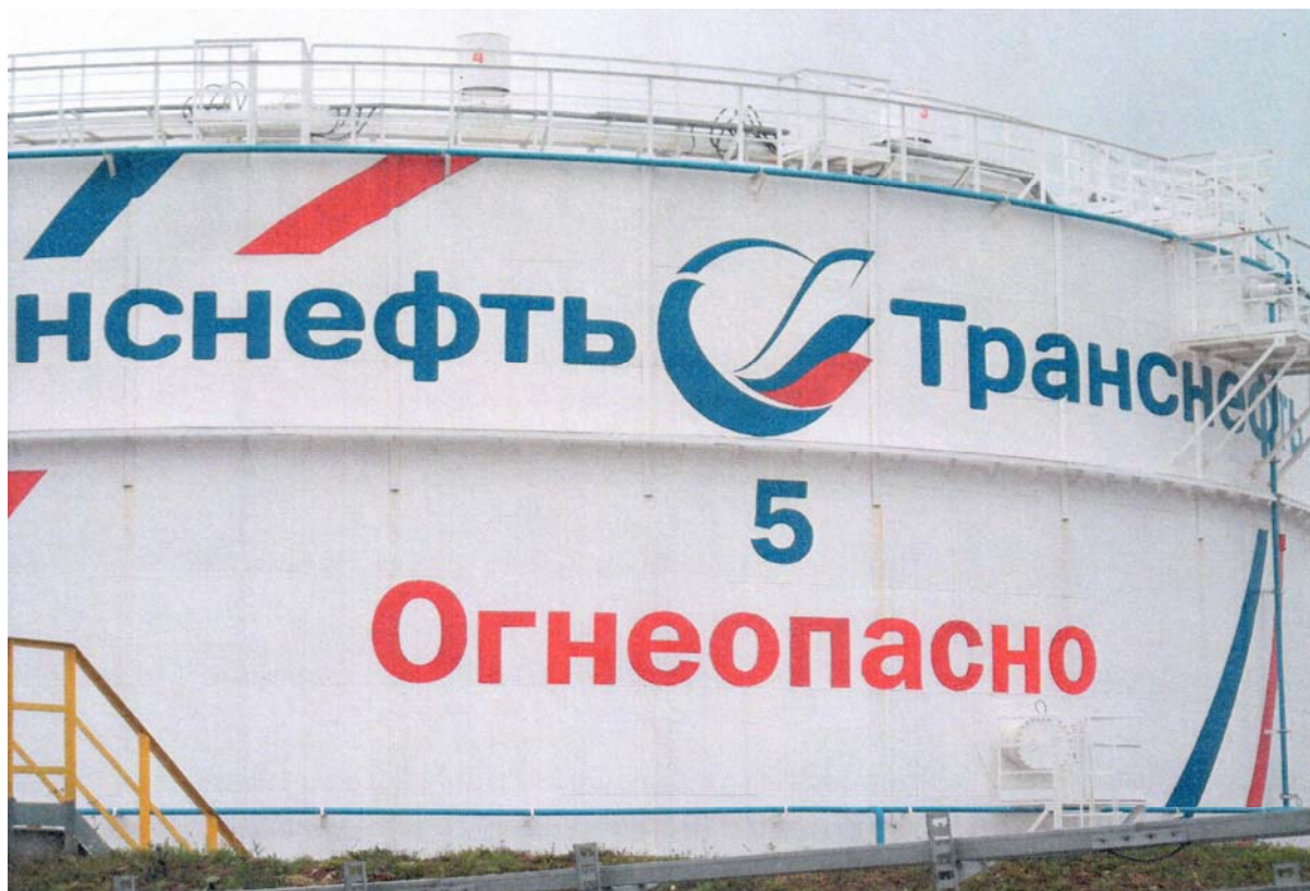
Рисунок 3 - Общий вид резервуара вертикального стального цилиндрического РВСП-10000
