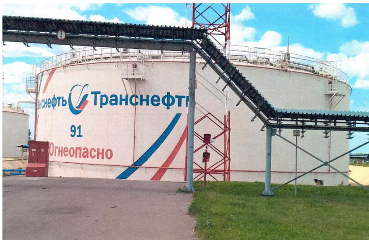
Рисунок 2 - Общий вид резервуара вертикального стального цилиндрического РВС-20000
