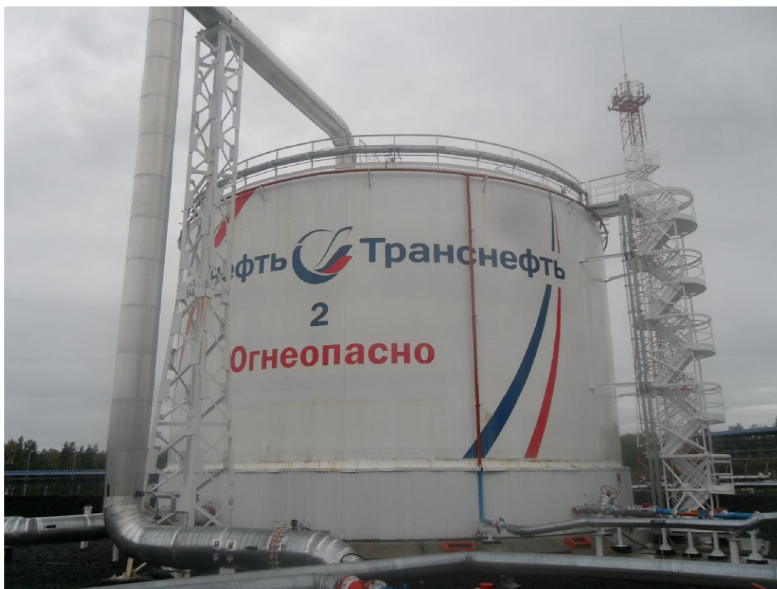
Рисунок 1 - Общий вид резервуара вертикального стального цилиндрического РВС-3000
