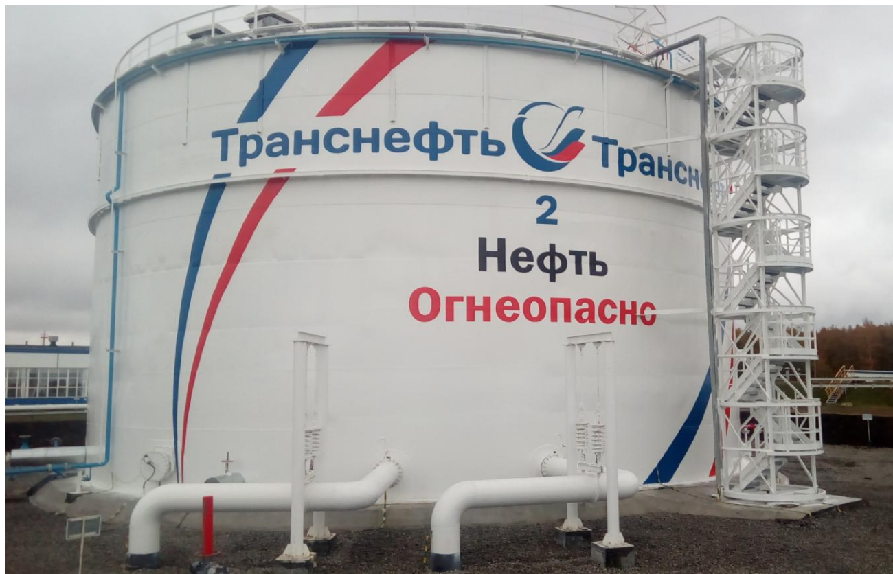
Рисунок 1 - Общий вид резервуара вертикального стального цилиндрического РВС-5000
