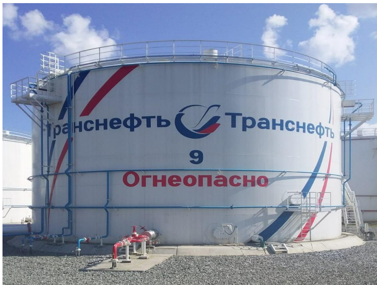
Рисунок 2 - Общий вид резервуаров вертикальных стальных цилиндрических РВСП-5000
