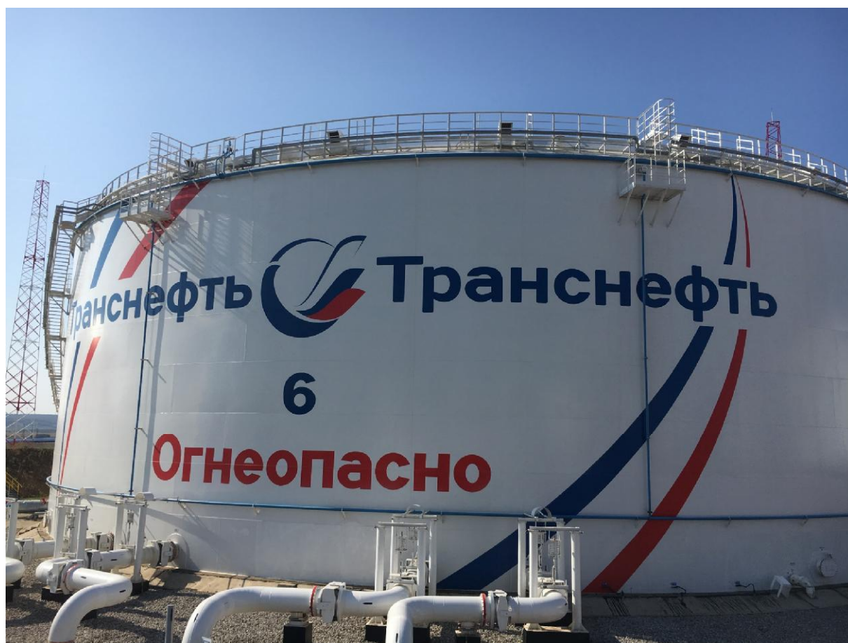
Рисунок 4 - Общий вид резервуаров вертикальных стальных цилиндрических РВСП-50000
