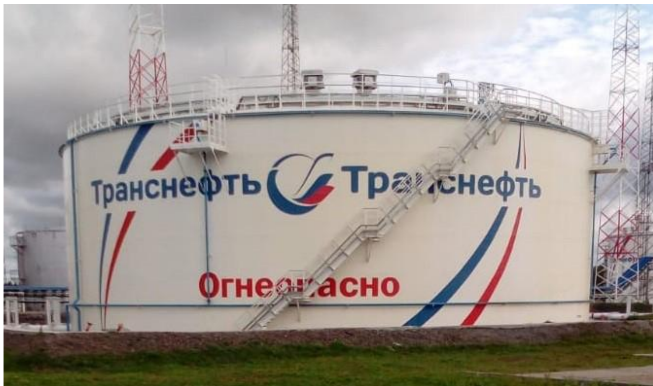
Рисунок 1 - Общий вид резервуаров вертикальных стальных цилиндрических РВС-10000
