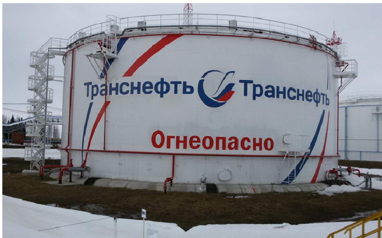
Рисунок 2 - Общий вид резервуаров вертикальных стальных цилиндрических РВСП-5000
