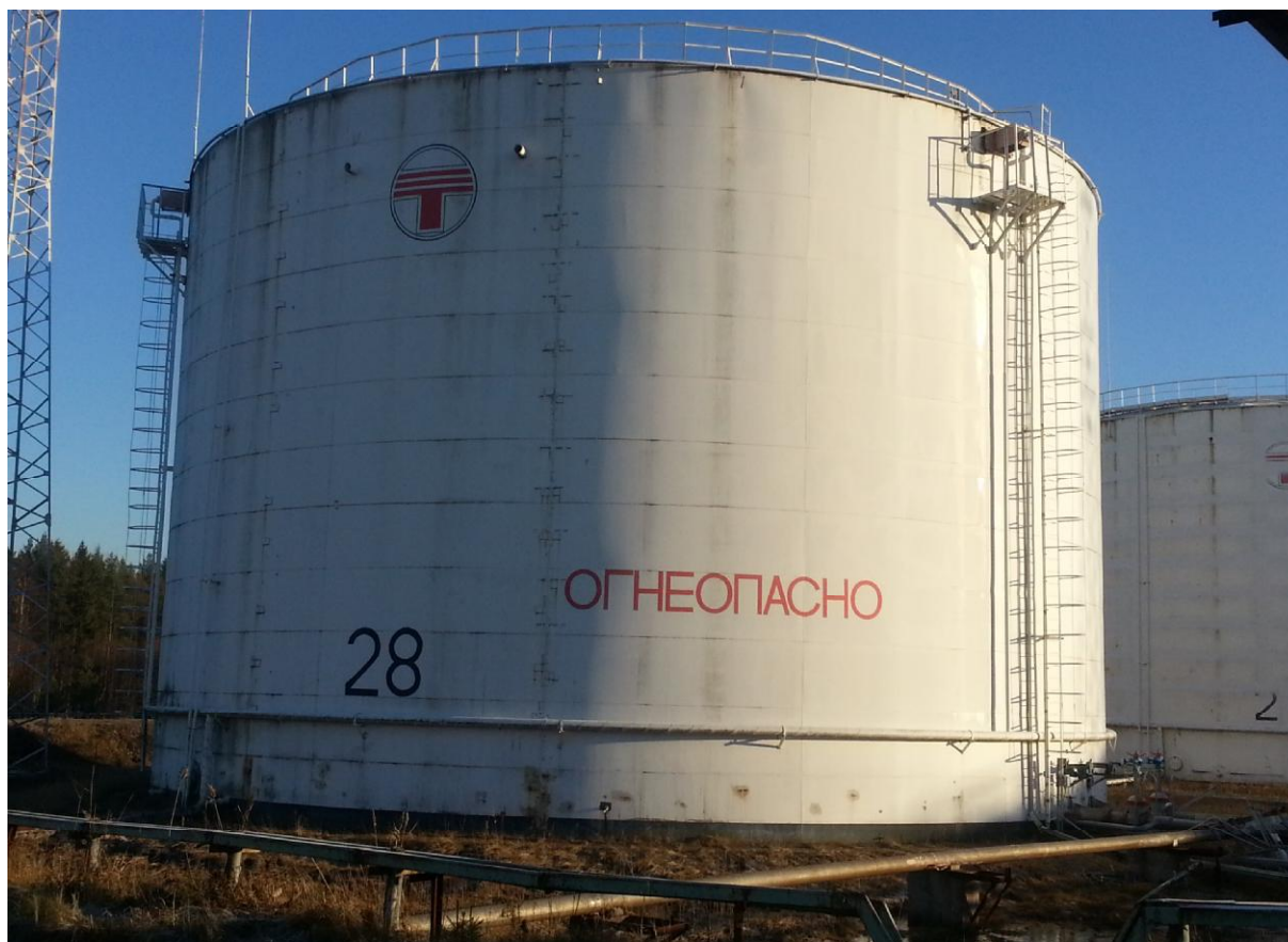
Рисунок 2 - Общий вид резервуара вертикального стального цилиндрического РВС-10000
