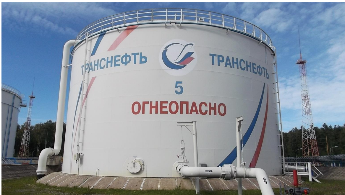
Рисунок 1 - Общий вид резервуара вертикального стального цилиндрического РВС-5000
