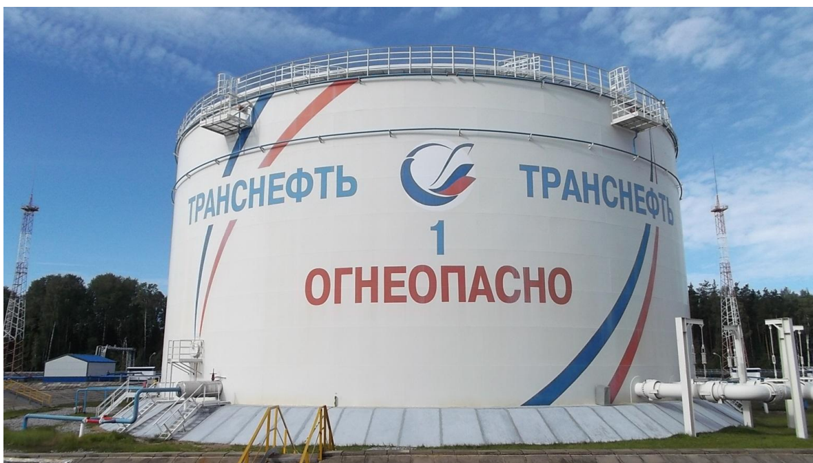
Рисунок 2 - Общий вид резервуара вертикального стального цилиндрического РВСП-20000
