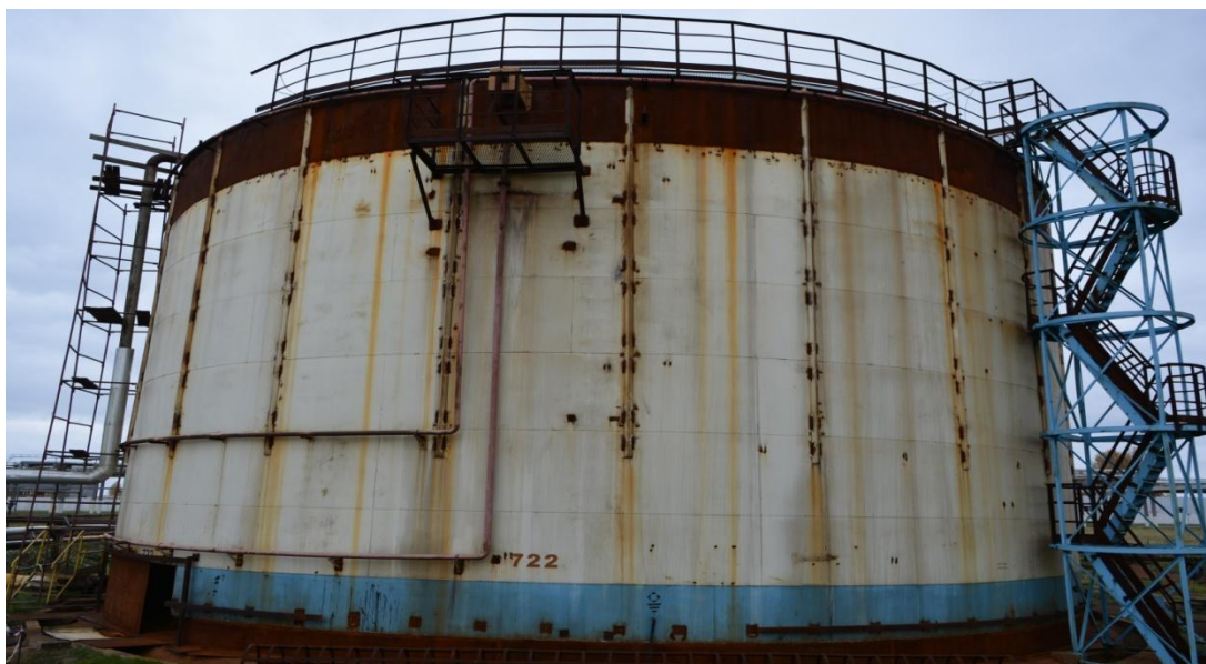
Рисунок 5 - Общий вид видимой части конструкции резервуара РВС-5000 № 722
