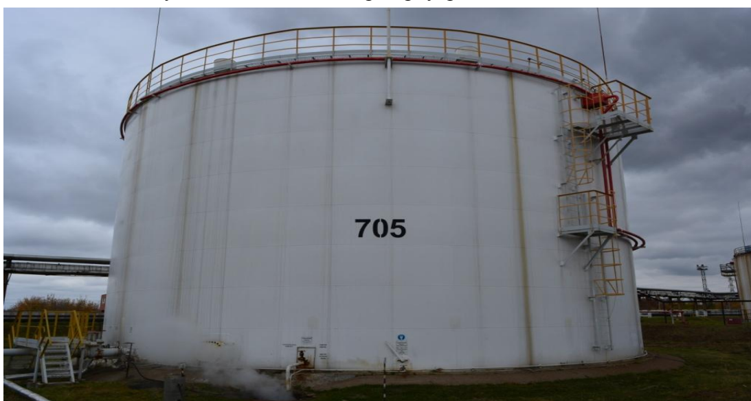
Рисунок 12 - Общий вид резервуара РВСП-5000 № 705
