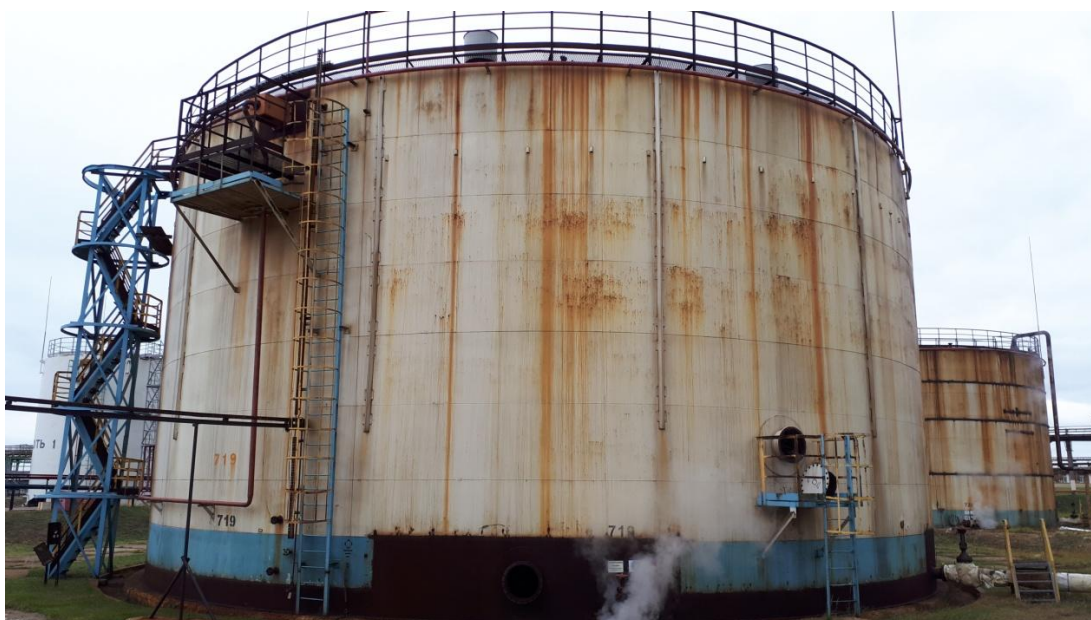
Рисунок 16 - Общий вид видимой части конструкции резервуара РВСП-5000 № 719
