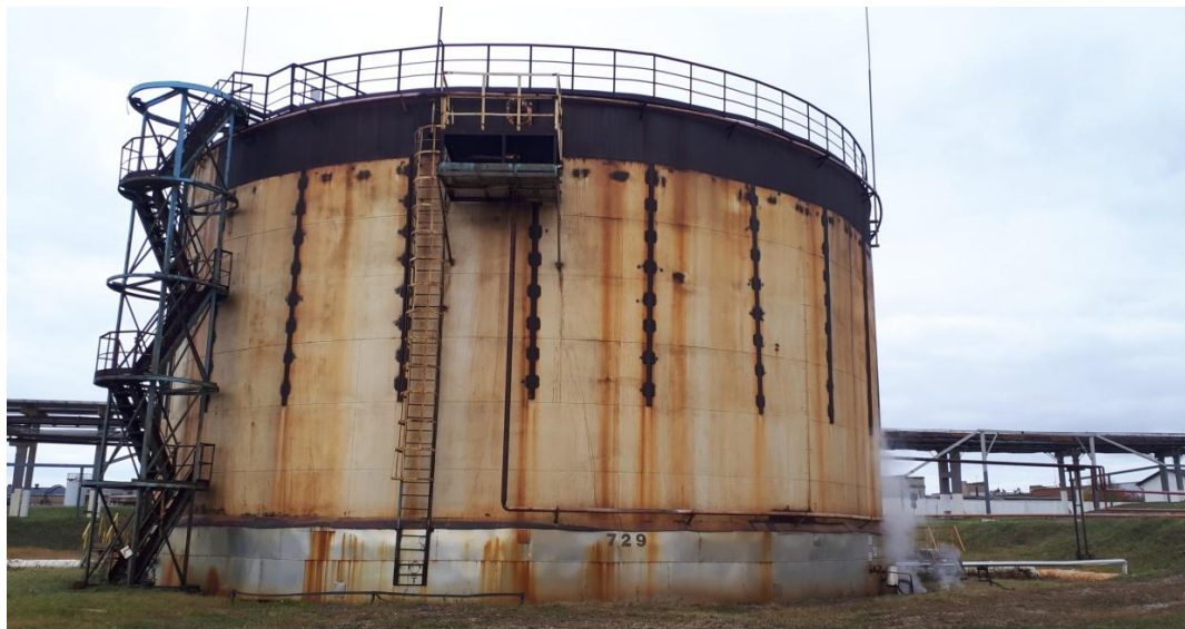
Рисунок 11 - Общий вид резервуара РВС-5000 № 729
