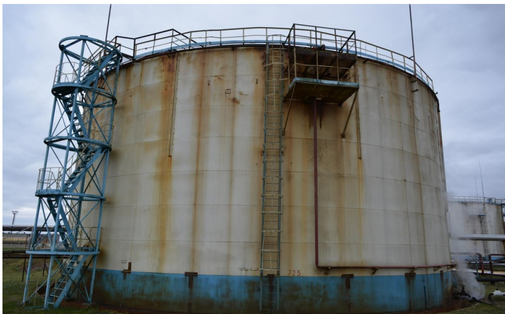
Рисунок 8 - Общий вид резервуара РВС-5000 № 725
