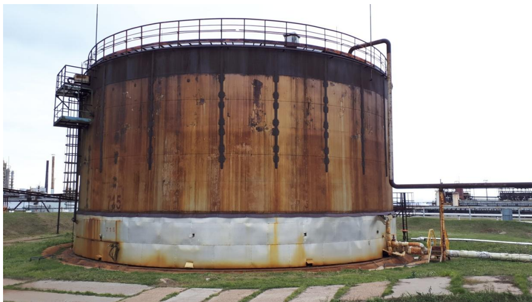
Рисунок 2 - Общий вид резервуара РВС-5000 № 715
