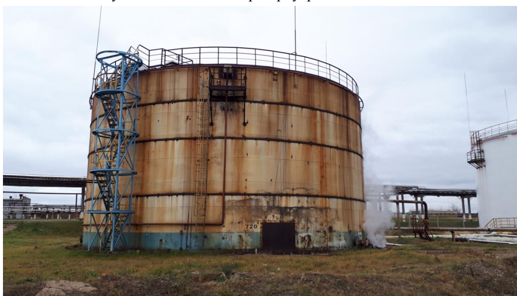
Рисунок 3 - Общий вид резервуара РВС-5000 № 720
