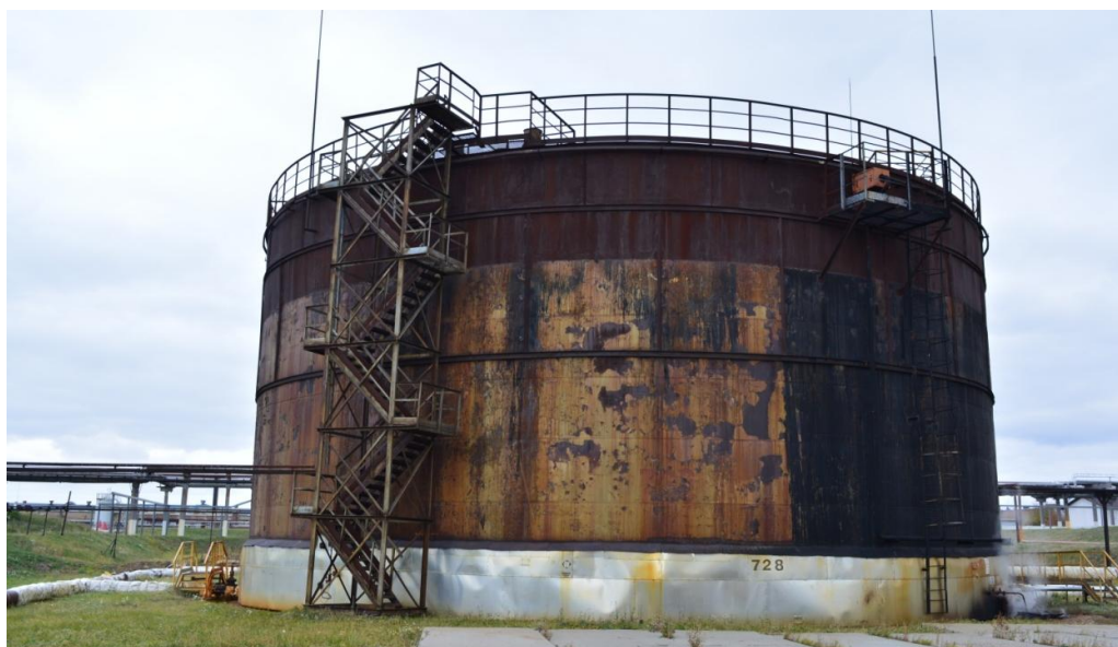
Рисунок 10 - Общий вид резервуара РВС-5000 № 728
