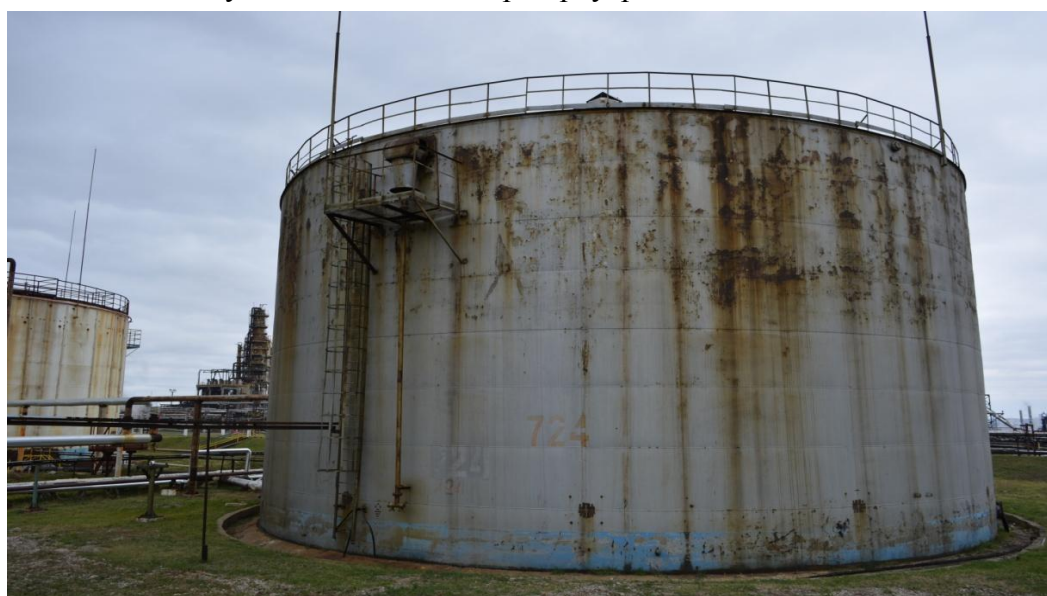
Рисунок 7 - Общий вид резервуара РВС-5000 № 724
