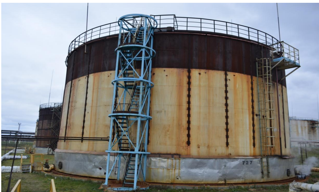
Рисунок 9 - Общий вид резервуара РВС-5000 № 727
