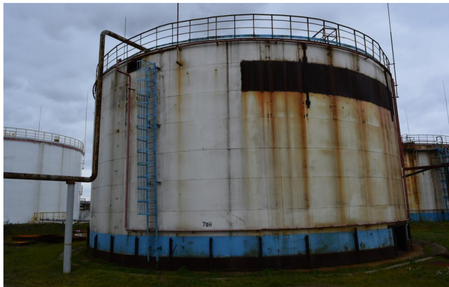
Рисунок 1 - Общий вид резервуара РВС-5000 № 708
