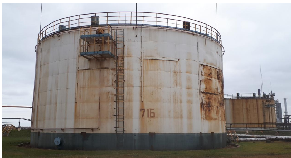
Рисунок 13 - Общий вид резервуара РВСП-5000 № 716
