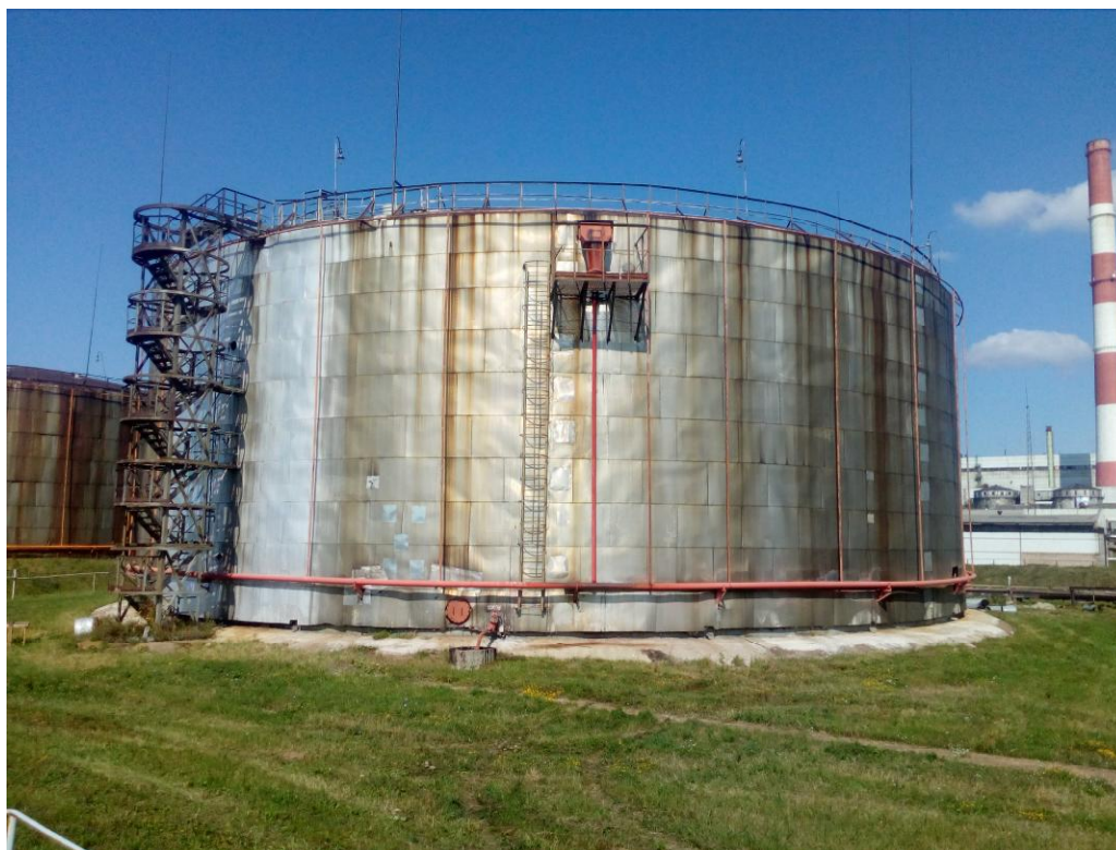
Рисунок 1 - Общий вид резервуара стального вертикального цилиндрического РВС-10000 № У-10-3348
