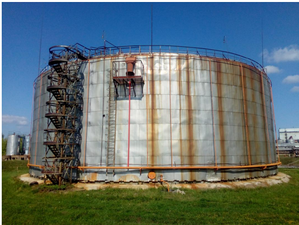
Рисунок 2 - Общий вид резервуара стального вертикального цилиндрического РВС-10000 № У-10-3405
