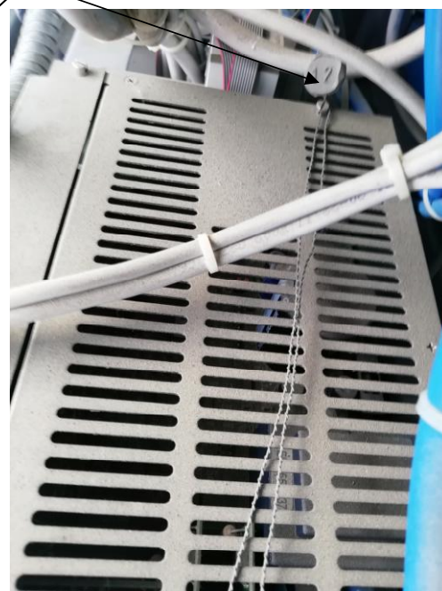
Рисунок 2 – Место пломбировки от несанкционированного доступа, обозначение мест нанесения знака поверки и пломб завода-изготовителя, на: модуль индикации Esiwelma, расходомер-счётчик массовый Micro Motion CMF 100
