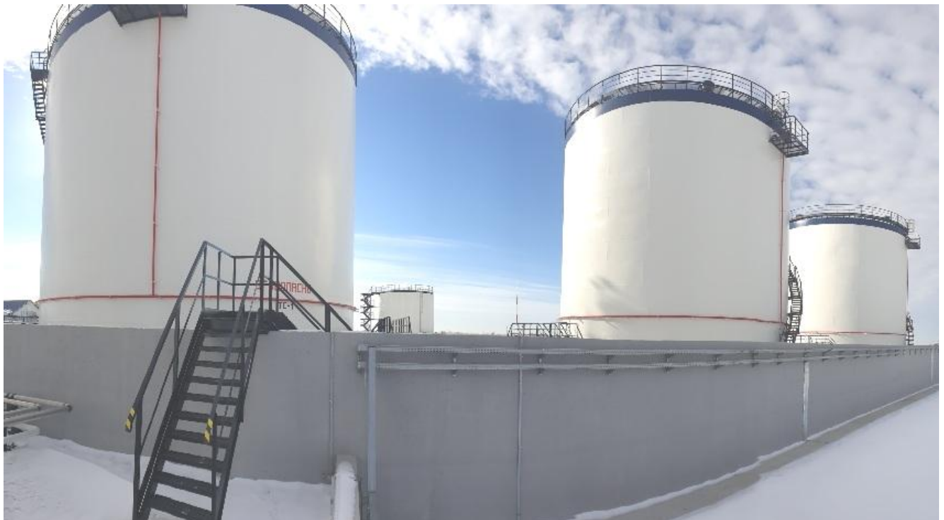
Рисунок 1 - Общий вид резервуаров
