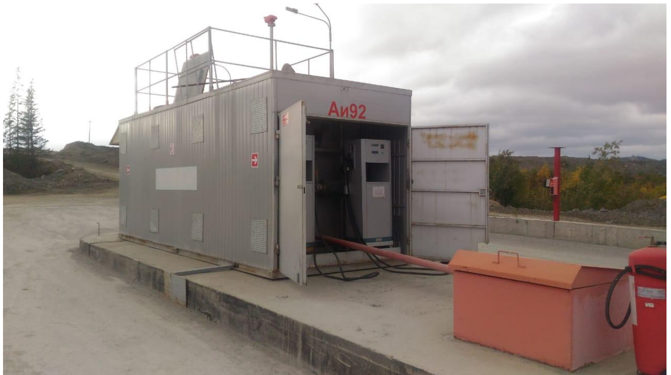
Рисунок 1 - Общий вид резервуара РГС-20
