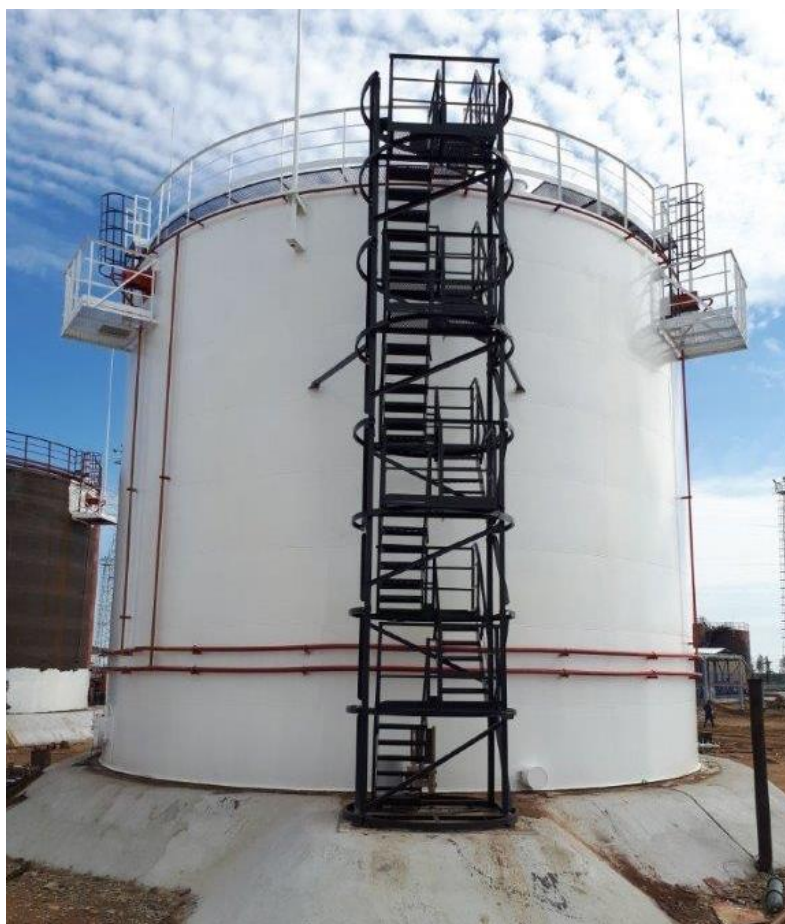
Рисунок 1 - Общий вид резервуара РВСП-2000
