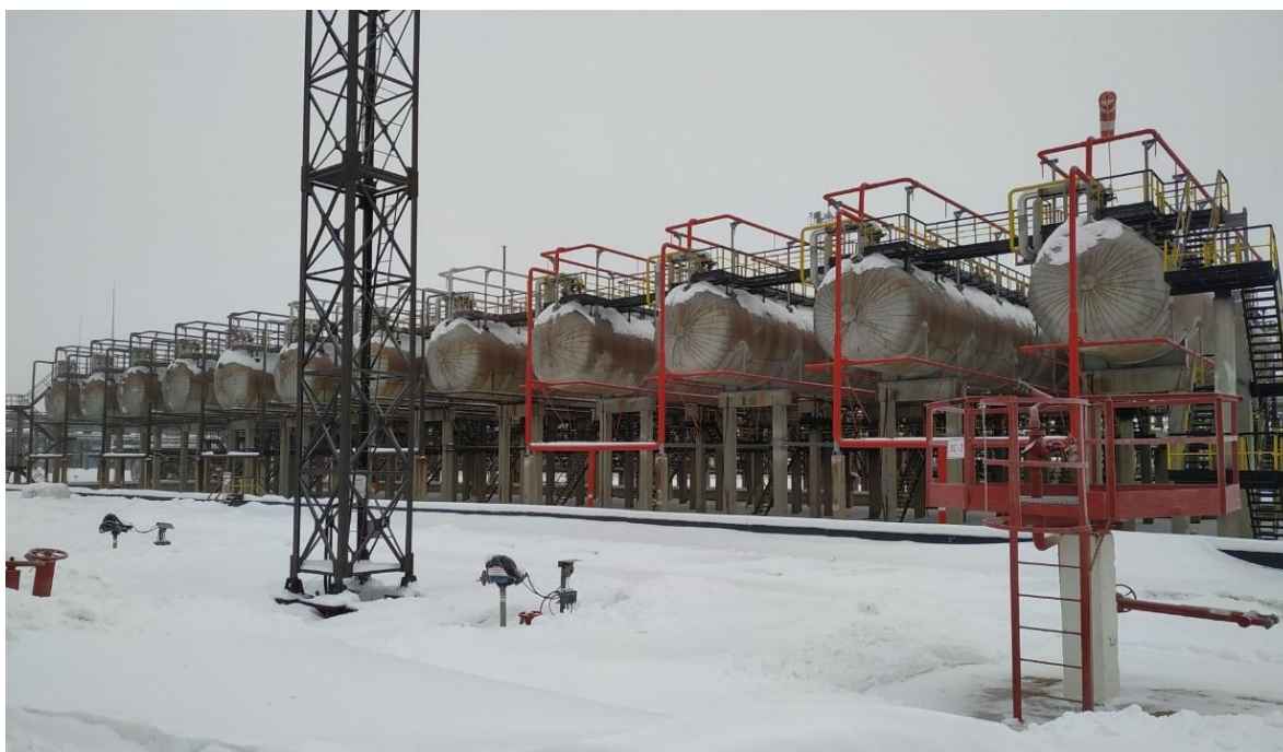
Рисунок 1 - Общий вид резервуара стального горизонтального цилиндрического РГС-200
