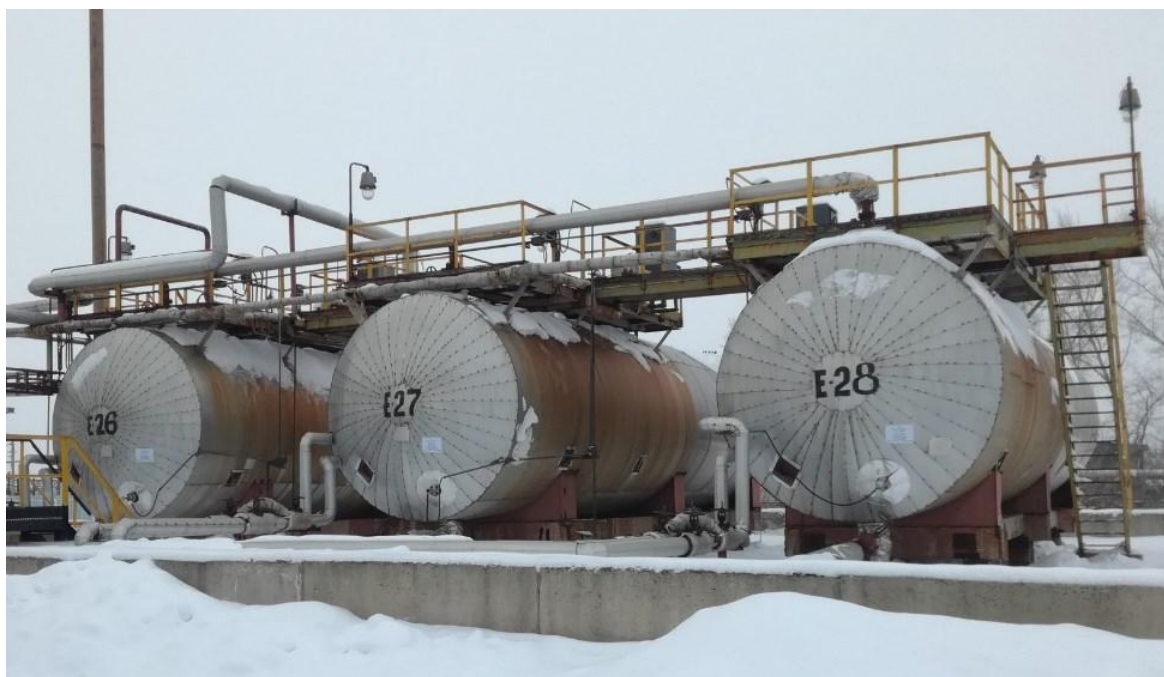
Рисунок 1 - Общий вид резервуара стального горизонтального цилиндрического РГС-100
