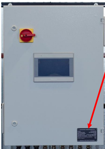
Рисунок 1 – Контроллер в шкафу общепромышленного исполнения
