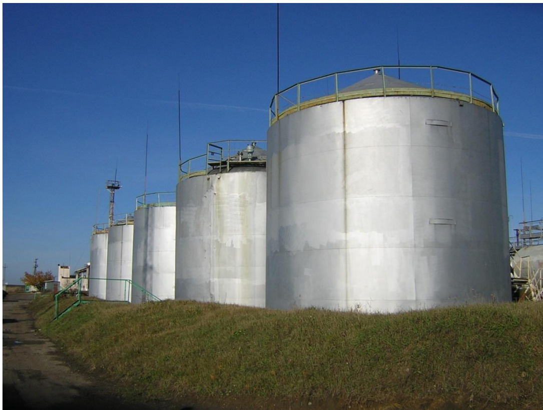
Рисунок 1 - Общий вид резервуаров стальных вертикальных цилиндрических РВС-400
