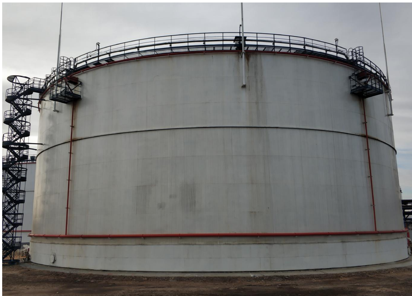
Рисунок 1 - Общий вид резервуара РВС-30000
