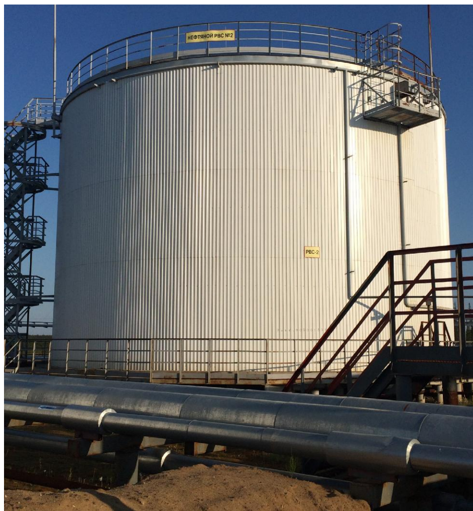
Рисунок 1 - Общий вид резервуара РВС-3000
