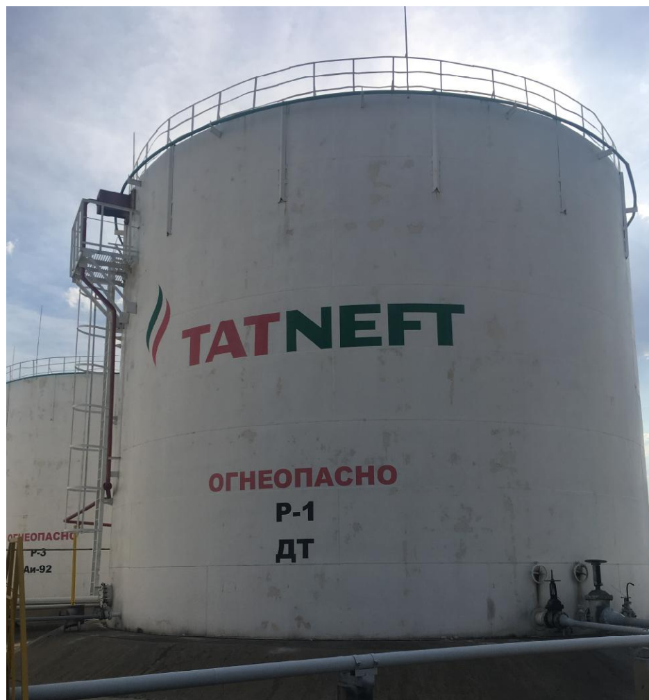
Рисунок 1 - Общий вид резервуара РВС-2000
