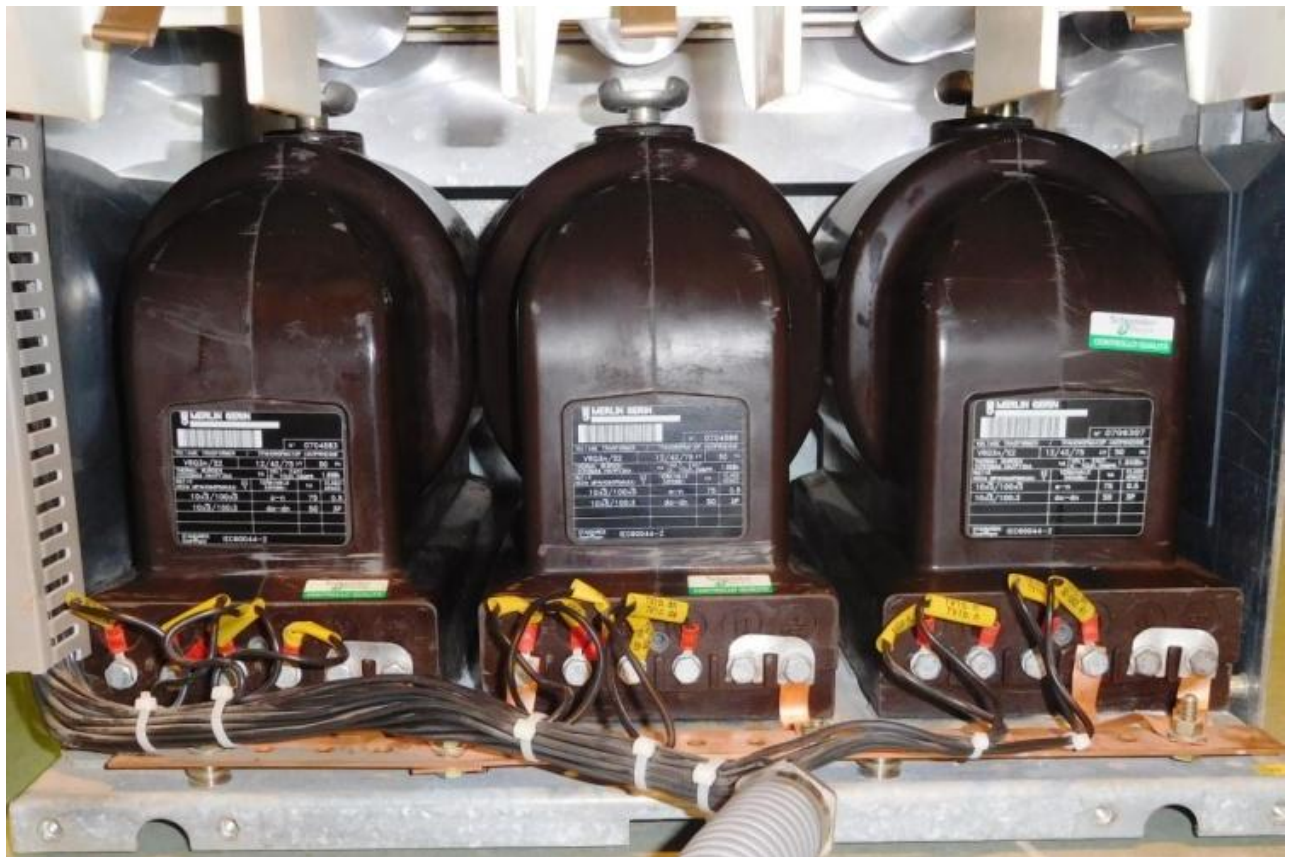
Рисунок 1 – Общий вид трансформаторов напряжения
