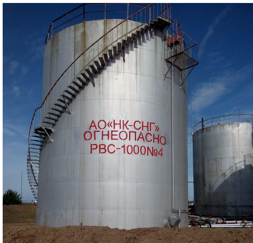
Рисунок 3 - Резервуар вертикальный стальной РВС-1000 №4
