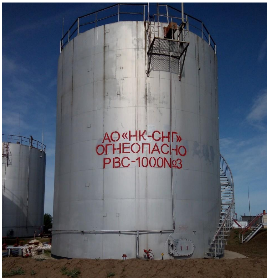
Рисунок 2 - Резервуар вертикальный стальной РВС-1000 №3
