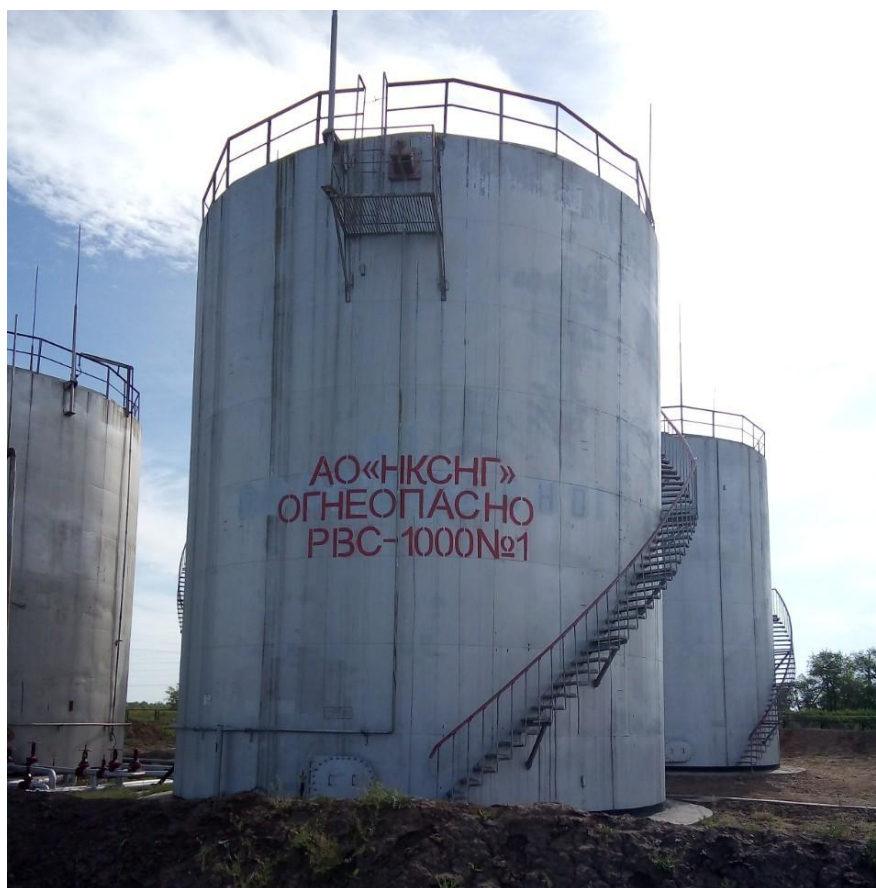
Рисунок 1 - Резервуар вертикальный стальной РВС-1000 №1
