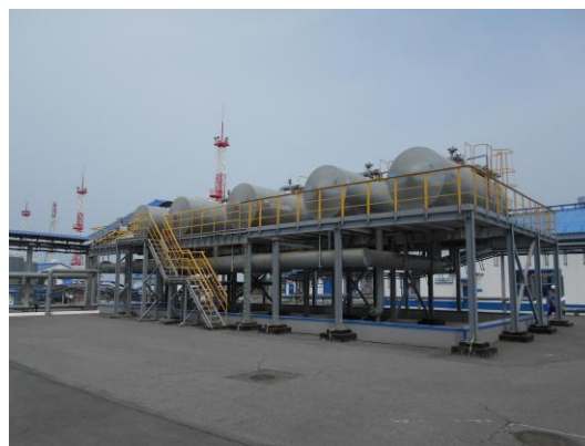
Рисунок 2 – Общий вид резервуаров РГС – 20 (3/17) №№ 153, 154, 155, 187, 188
