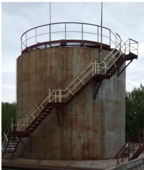
Рисунок 1 – Общий вид резервуаров РВС-400
