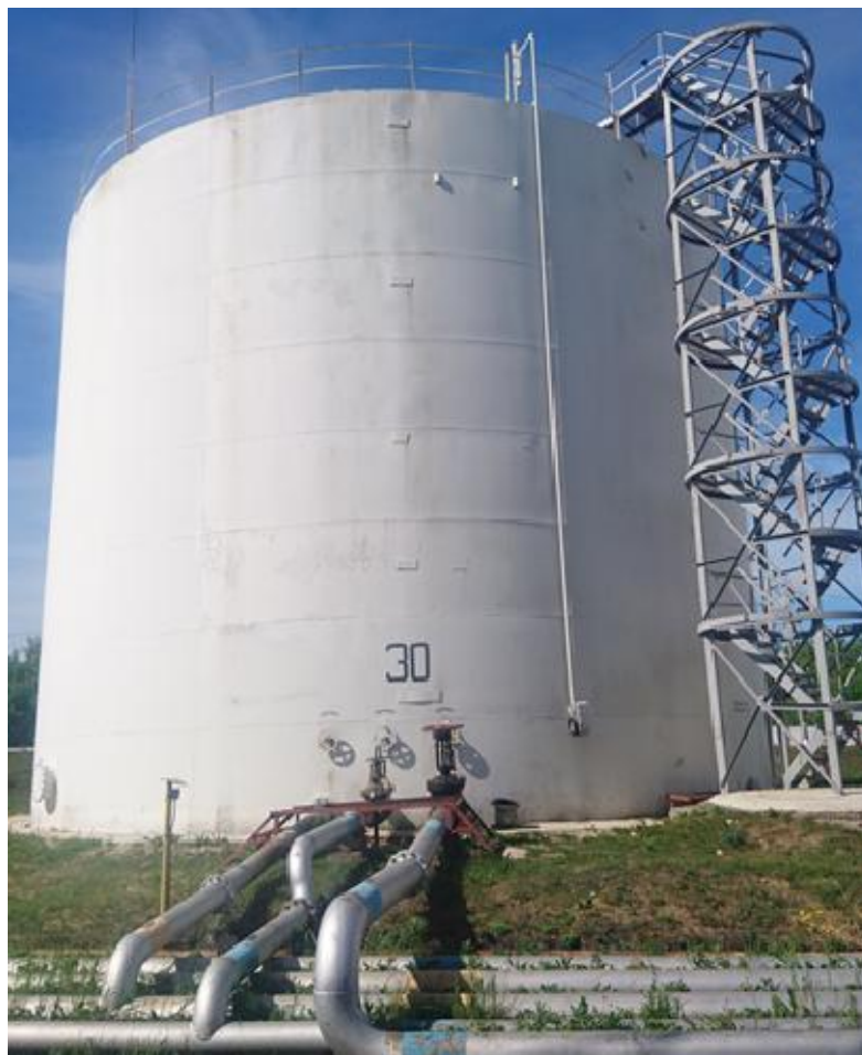
Рисунок 1 – Общий вид резервуара стального вертикального цилиндрического РВС-2000 № 30
