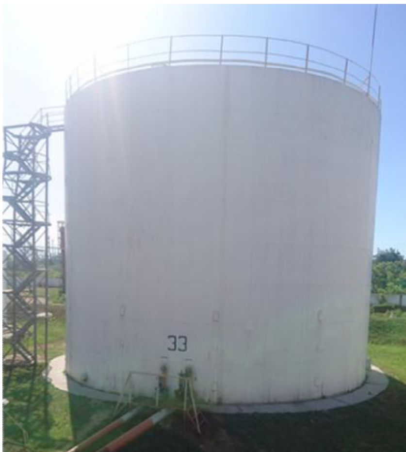
Рисунок 2 – Общий вид резервуара стального вертикального цилиндрического РВС-2000 № 33
