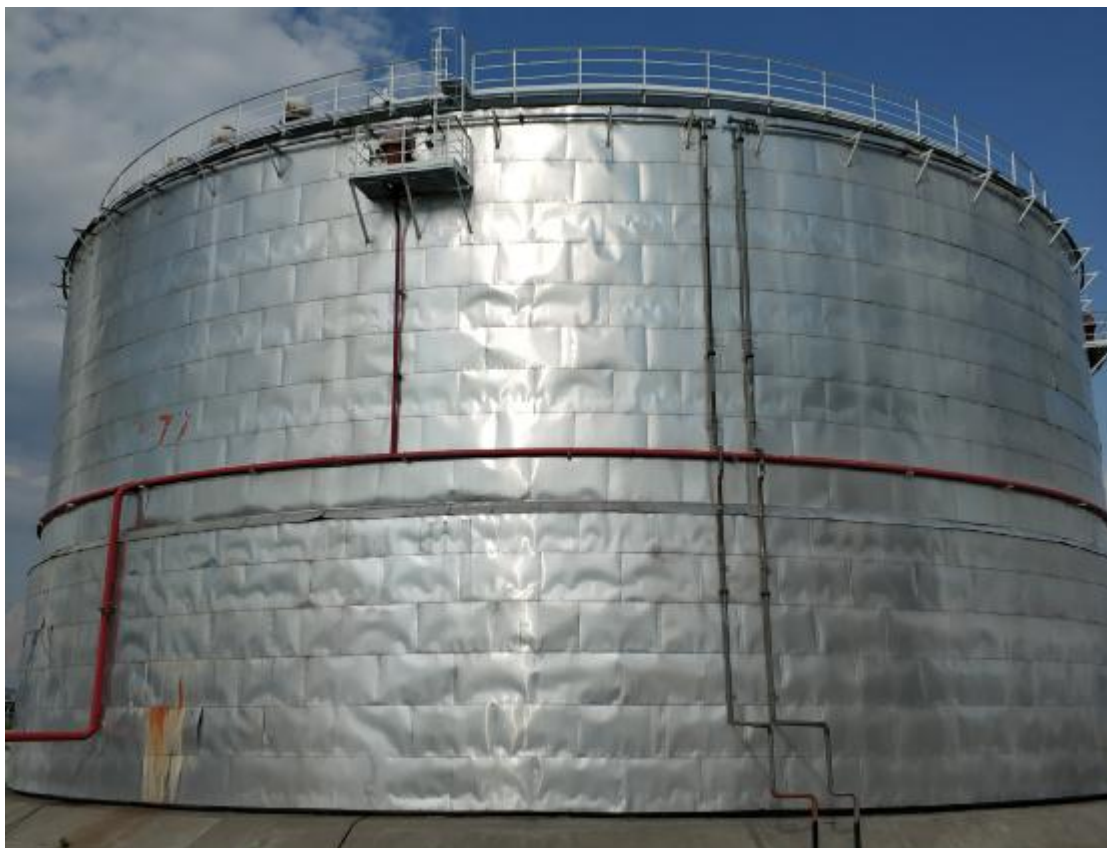
Рисунок 1 – Общий вид резервуара РВС-20000
