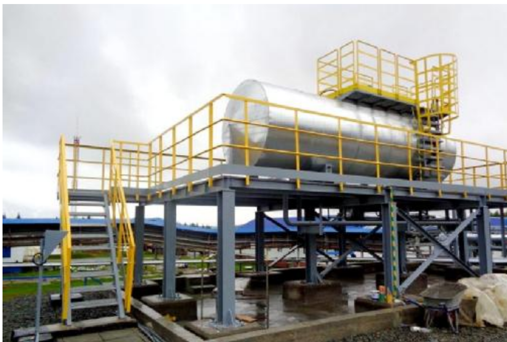
Рисунок 1 – Общий вид резервуара № 359
