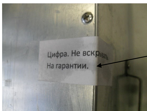
Рисунок 2 – Место нанесения пломбировки от несанкционированного доступа.
