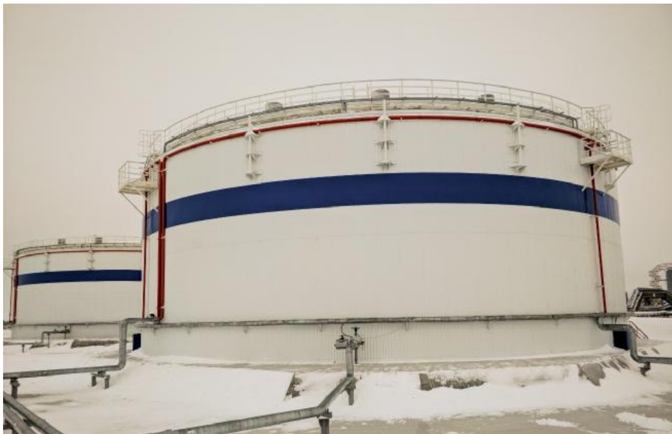
Рисунок 1 – Общий вид резервуаров вертикальных стальных цилиндрических РВС-10000, заводские номера 14 и 15.
