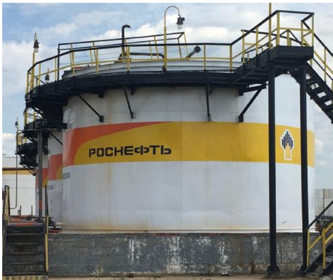
Рисунок 1 – Общий вид резервуара стального вертикального цилиндрического РВС-335
