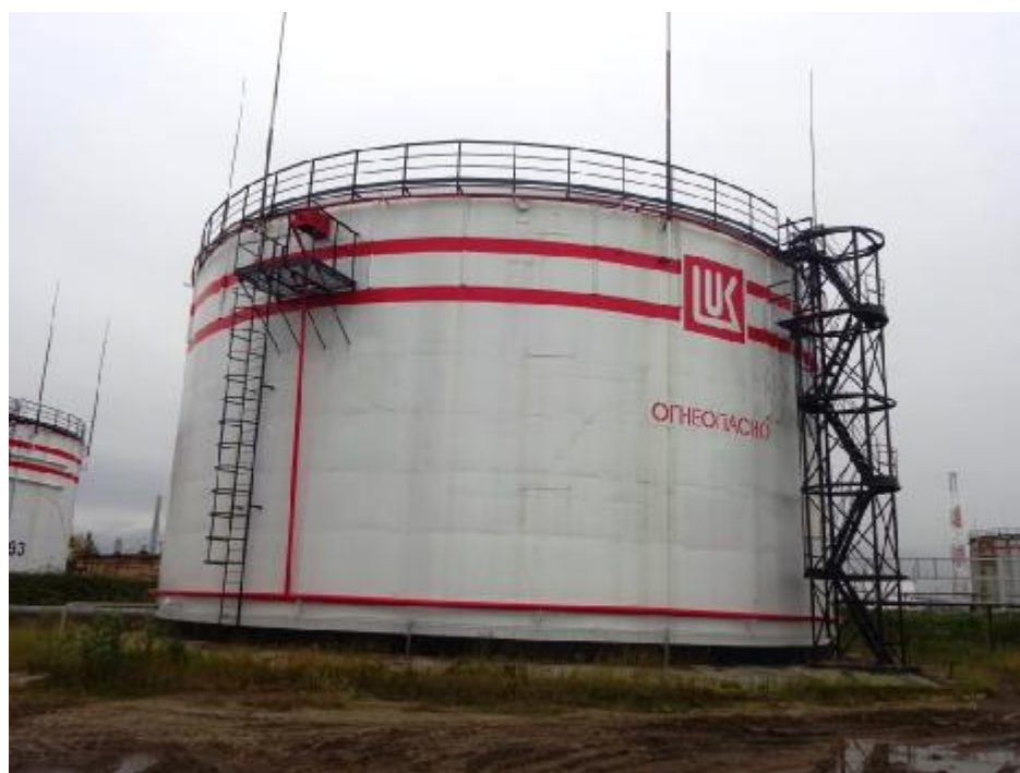
Рисунок 2 – Общий вид резервуаров РВСП-5000 №№ 91, 93, 94
