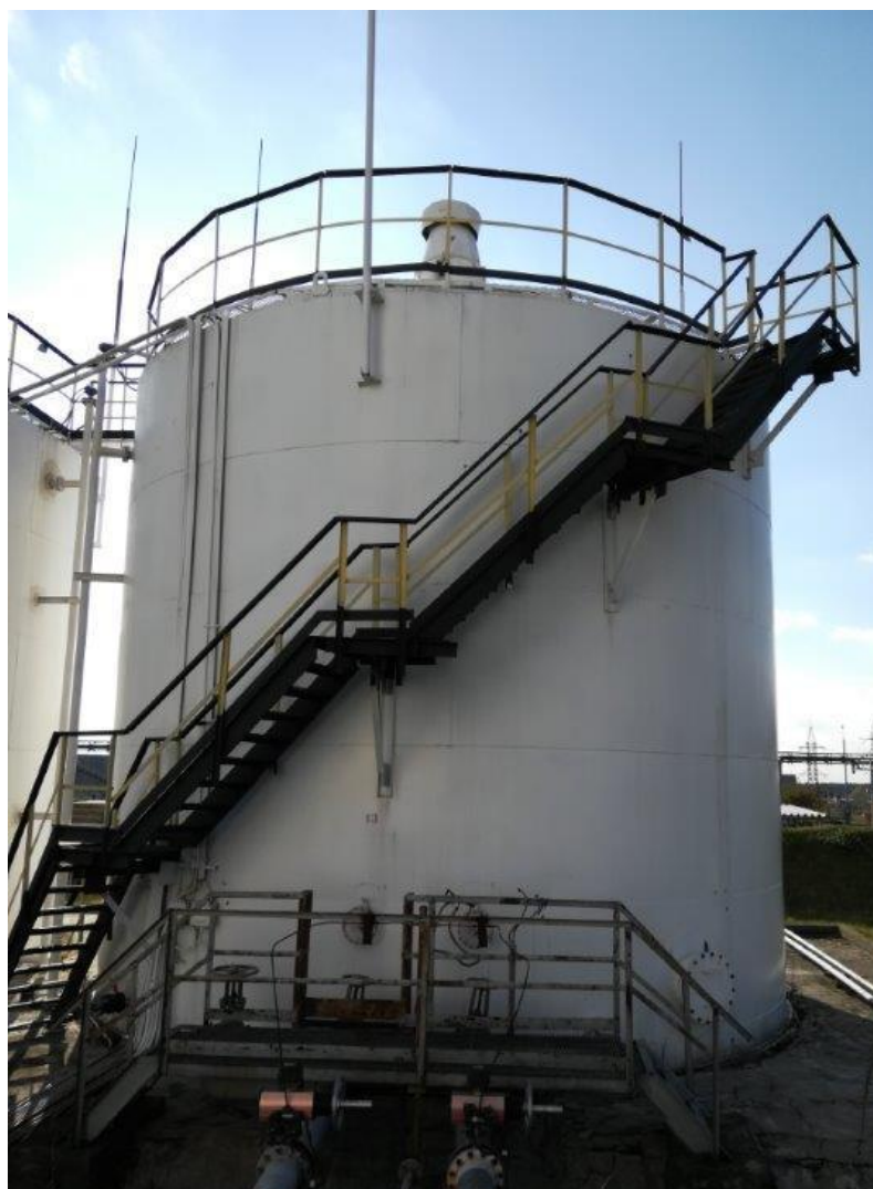
Рисунок 1 – Общий вид резервуара стального вертикального цилиндрического РВС-400
