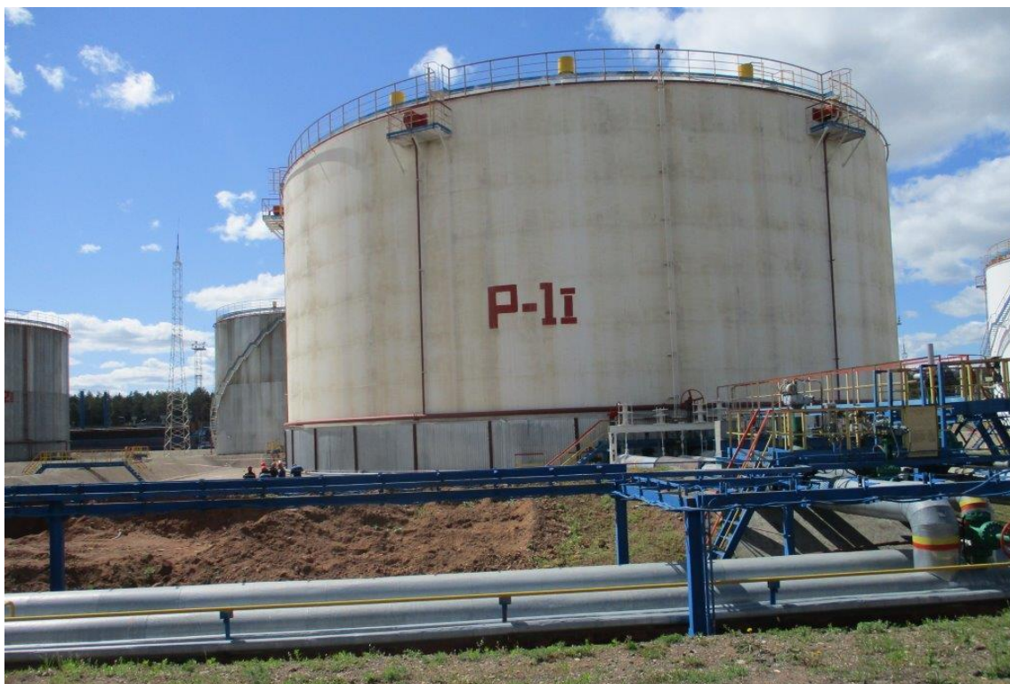
Рисунок 1 – Общий вид резервуара стального вертикального цилиндрического с понтоном РВСП-20000
